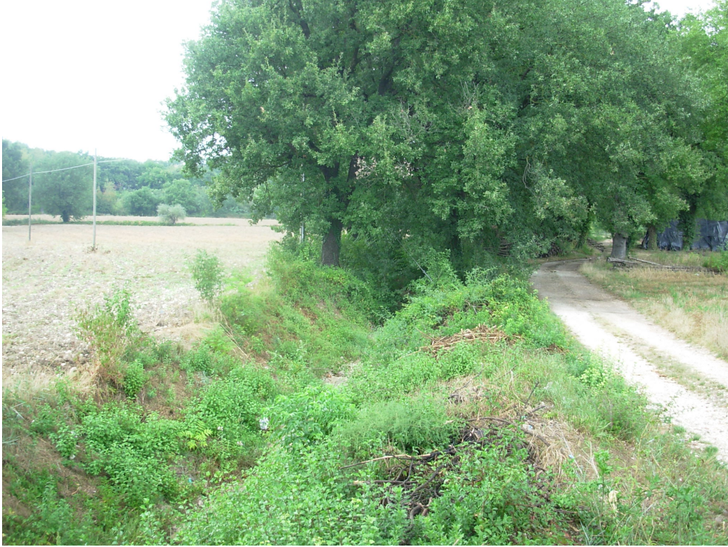
Figura 15. Fosso di S. Antonio in corrispondenza della sez.61 (vista verso valle).
