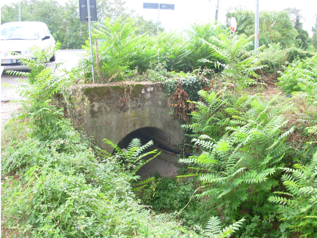
Figura 13. Fosso di S. Antonio, manufatto di attraversamento della SR 418.
