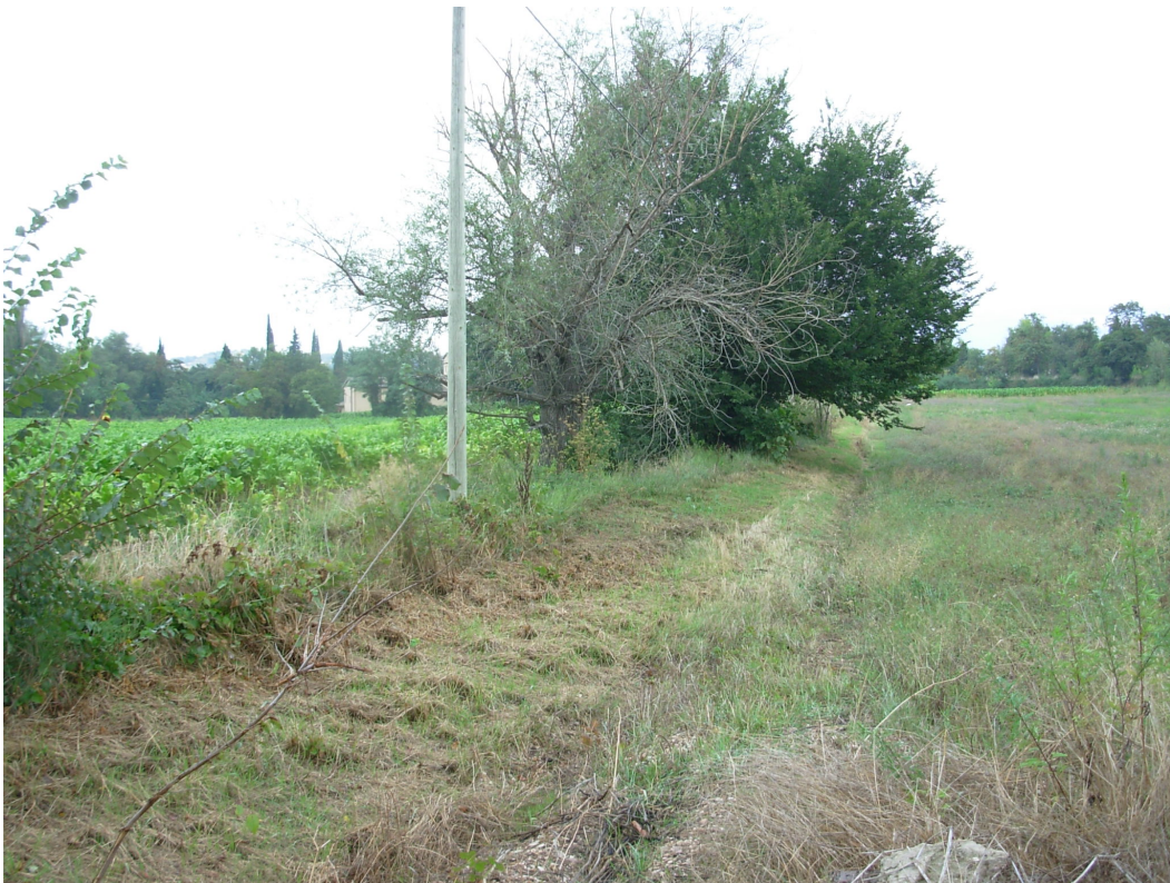
Figura 10. Canale dei Mulini in corrispondenza del viadotto Mulini.
