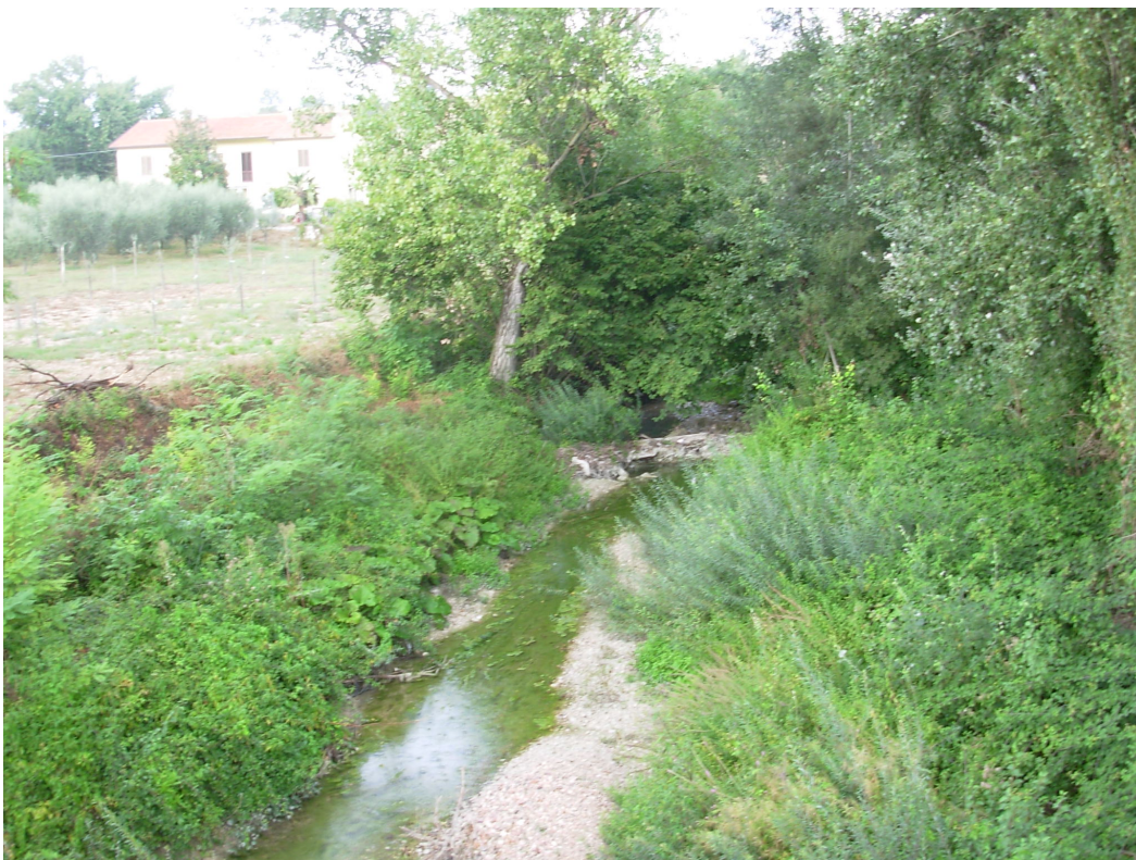
Figura 1. Torrente Marroggia in corrispondenza del ponte esistente sulla SR 418 (vista verso valle).
