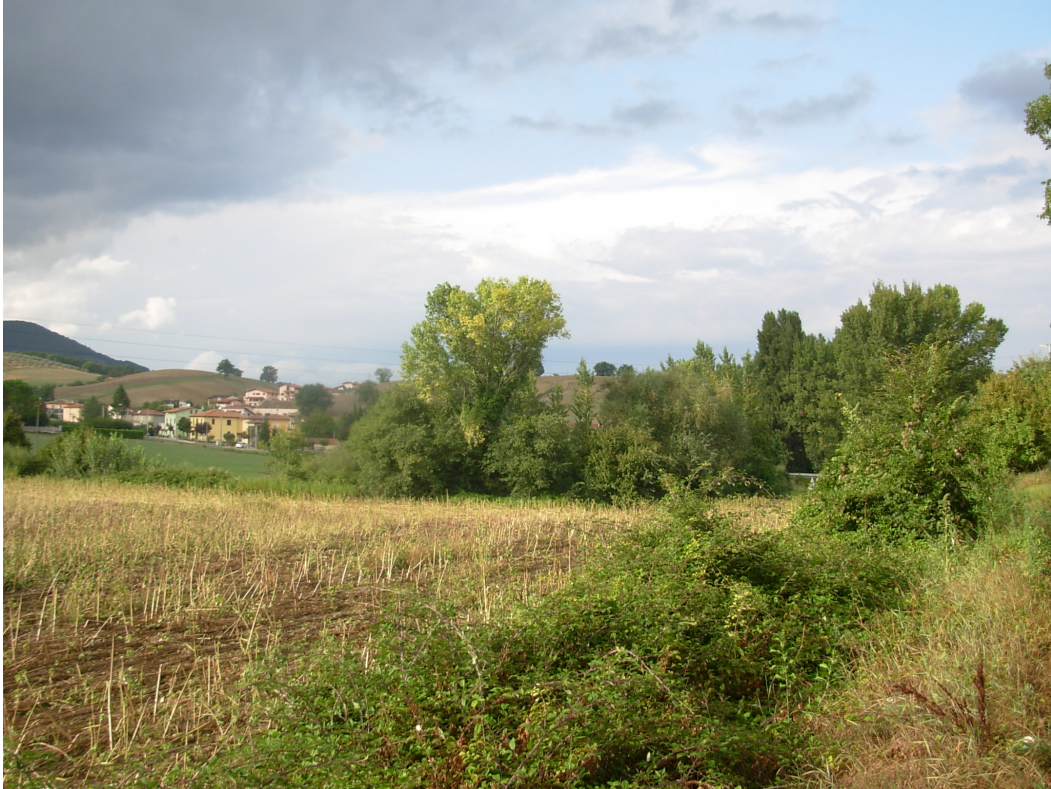
Figura 5. Torrente Marroggia, area in destra idraulica in corrispondenza del viadotto Marroggia I nel tratto in affiancamento del corso d'acqua.
