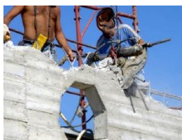
Demolizione eseguita manualmente
