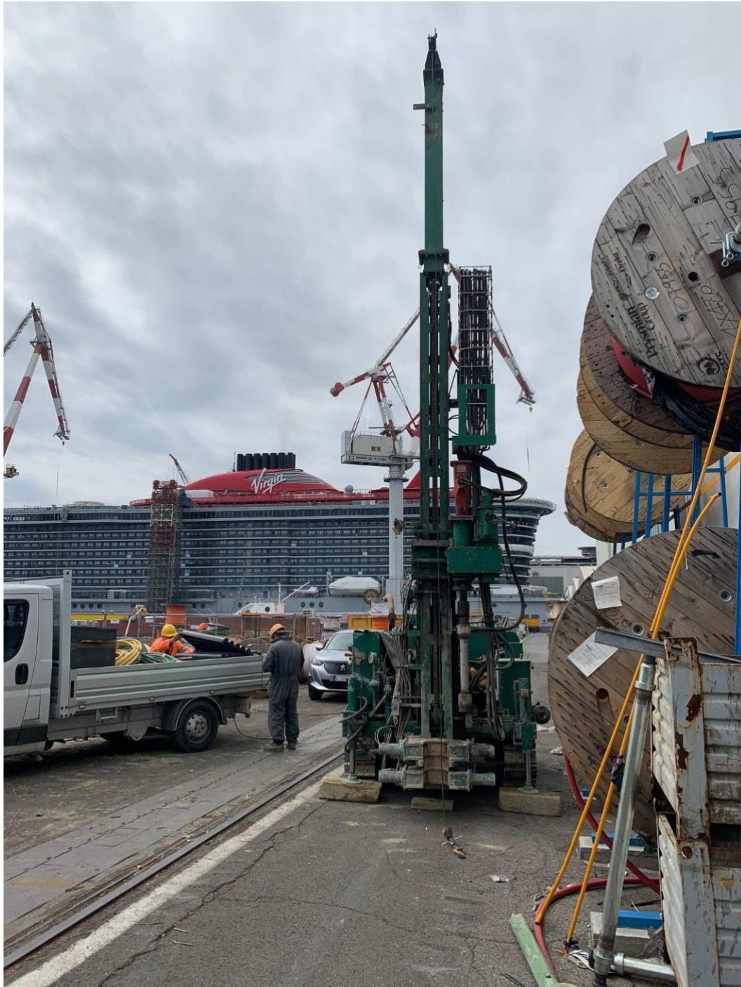
Piazzamento sondaggio ST7
