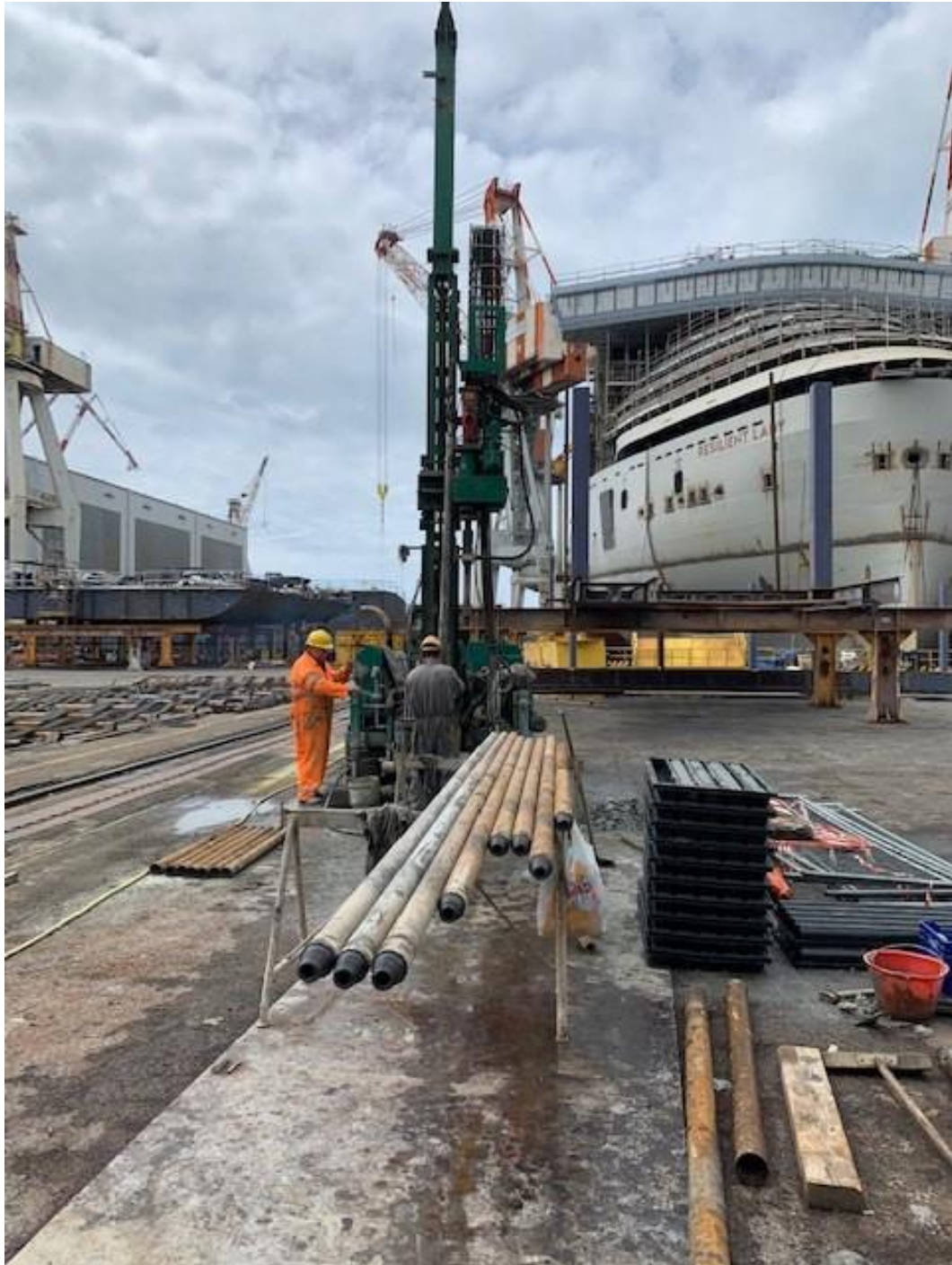
Piazzamento sondaggio ST1
