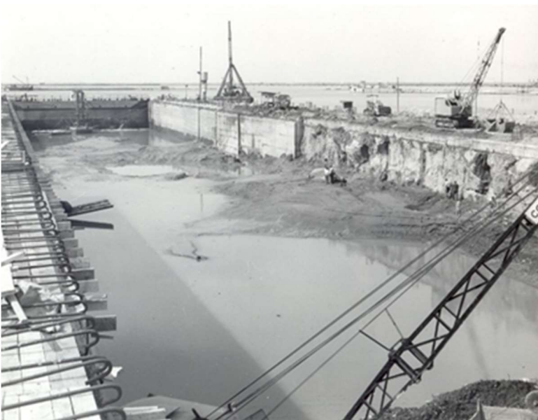
Figura 4.9 – Scavo del bacino - Diaframmi e cassoni già scavati a vista
