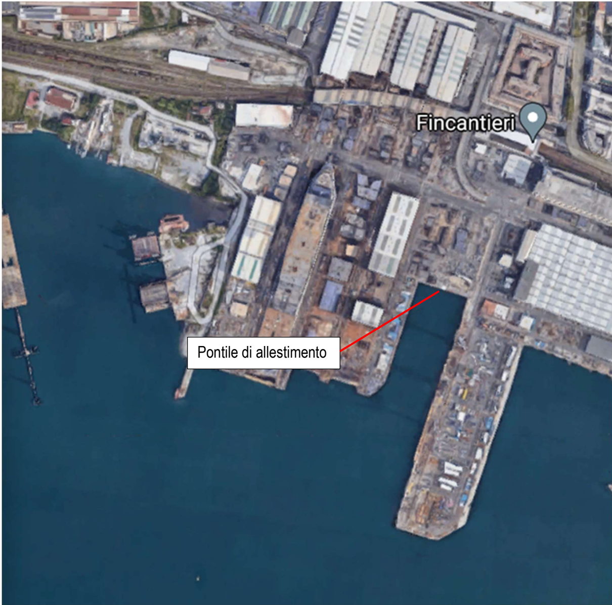
Figura 5.4 – Pontile di allestimento
