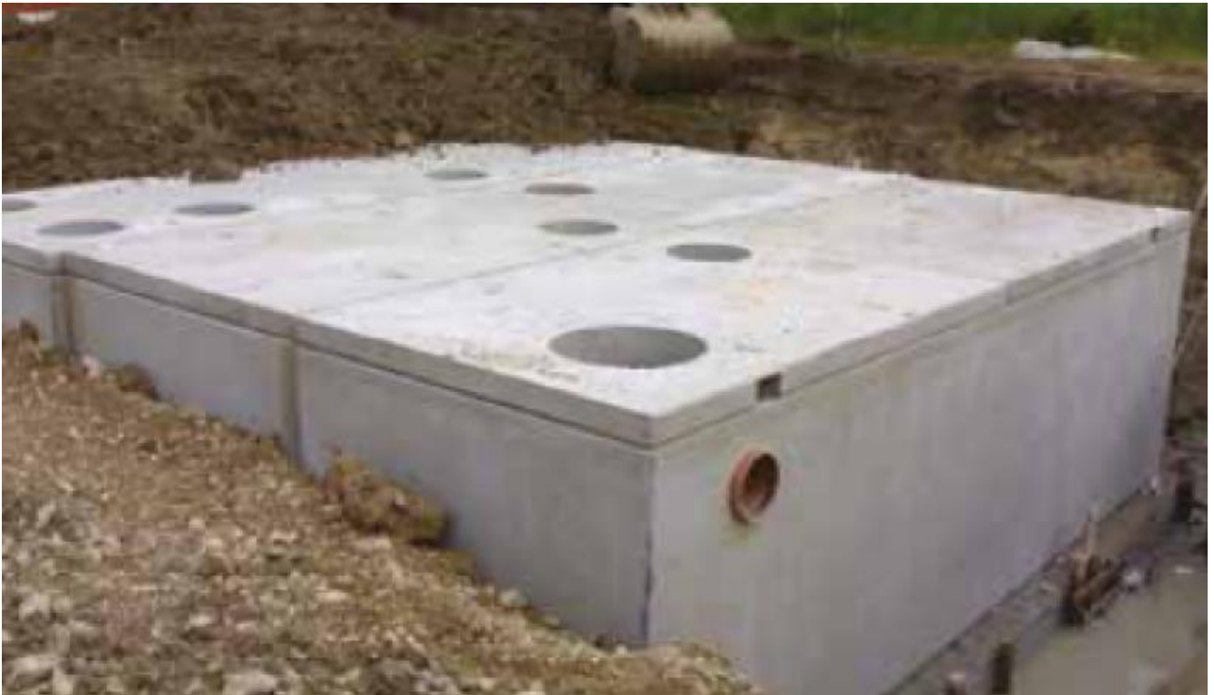
Figura 13 – Esempio di vasche di contenimento collegate
