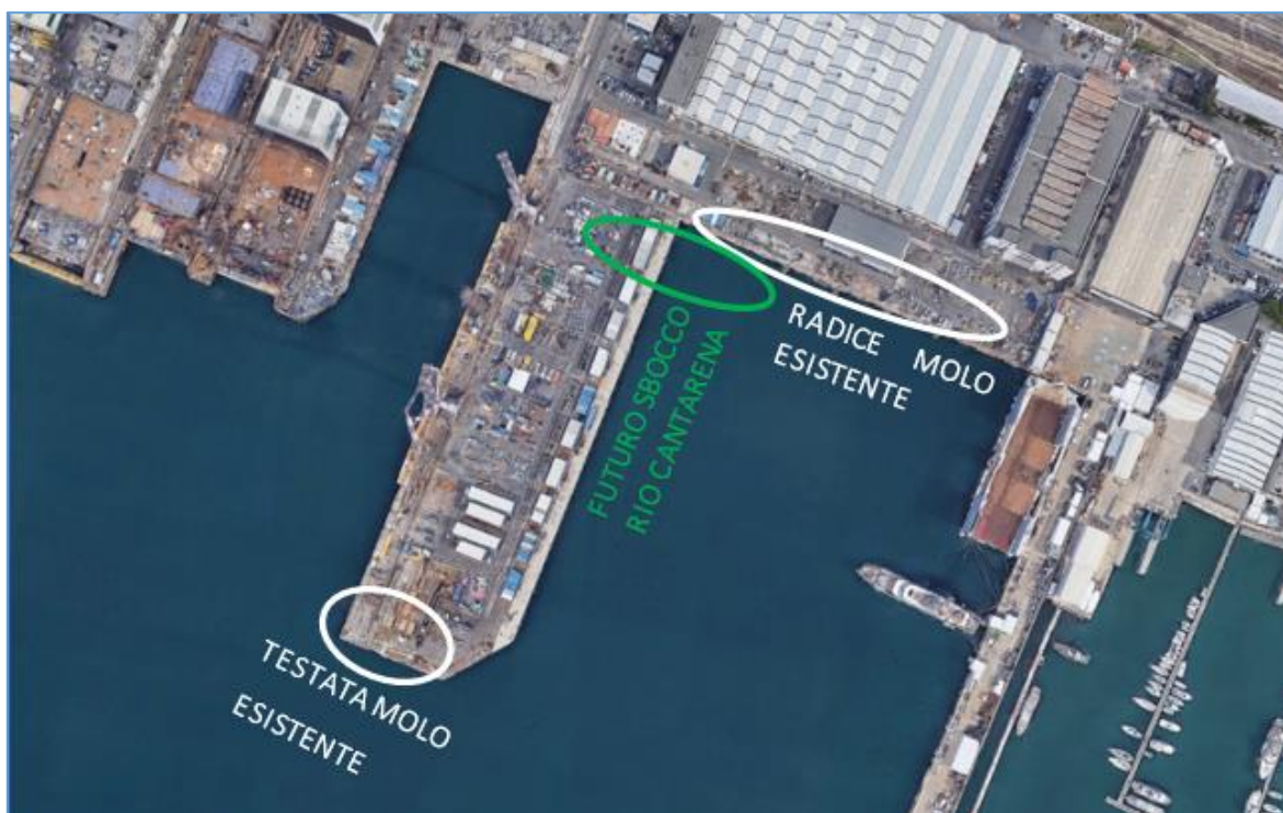
Figura 3.1 - Individuazione delle aree non oggetto del PFTE e del tratto interessato dallo sbocco del Rio Cantarena
