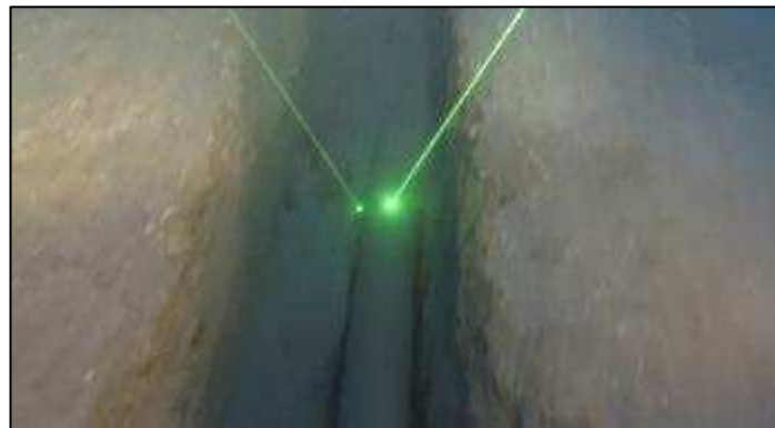
Figura 6.3.4: Esempio di trincea realizzata mediante trenching
