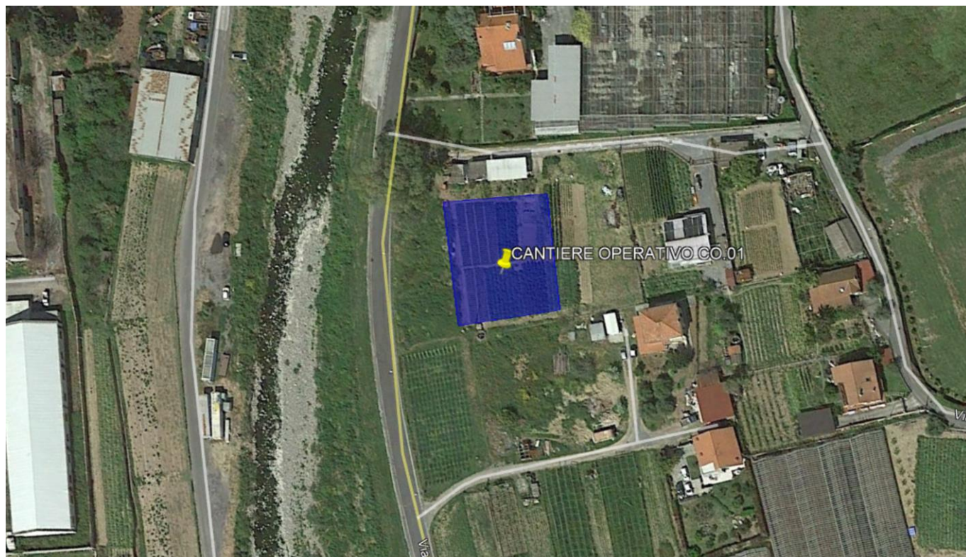
Vista area di cantiere
