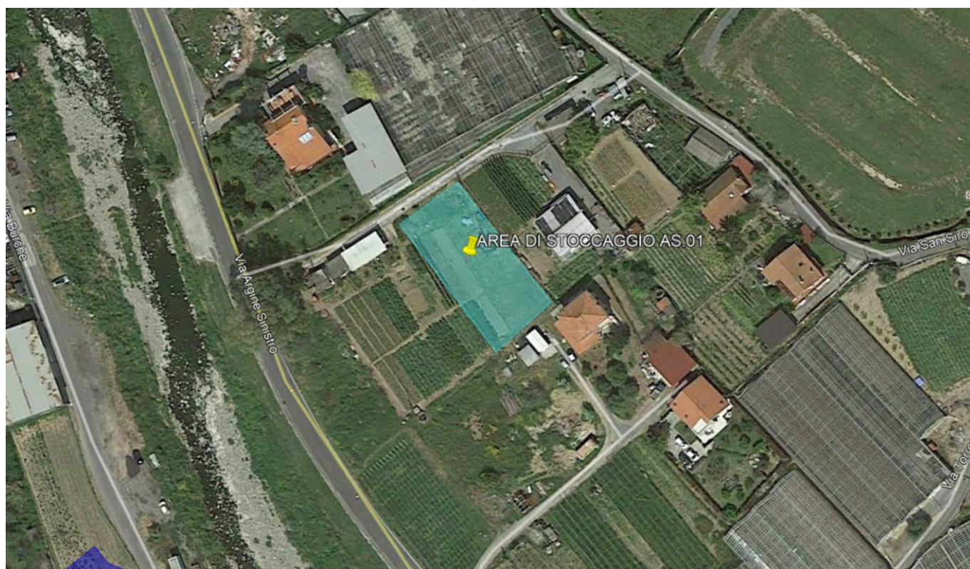
Vista area di cantiere
