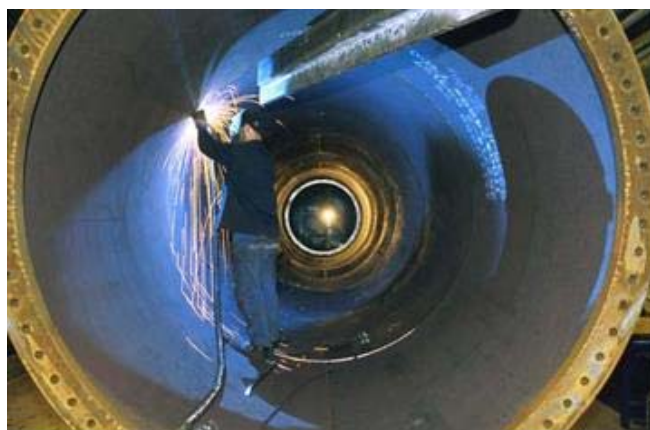
Figura 10: interno di una torre
