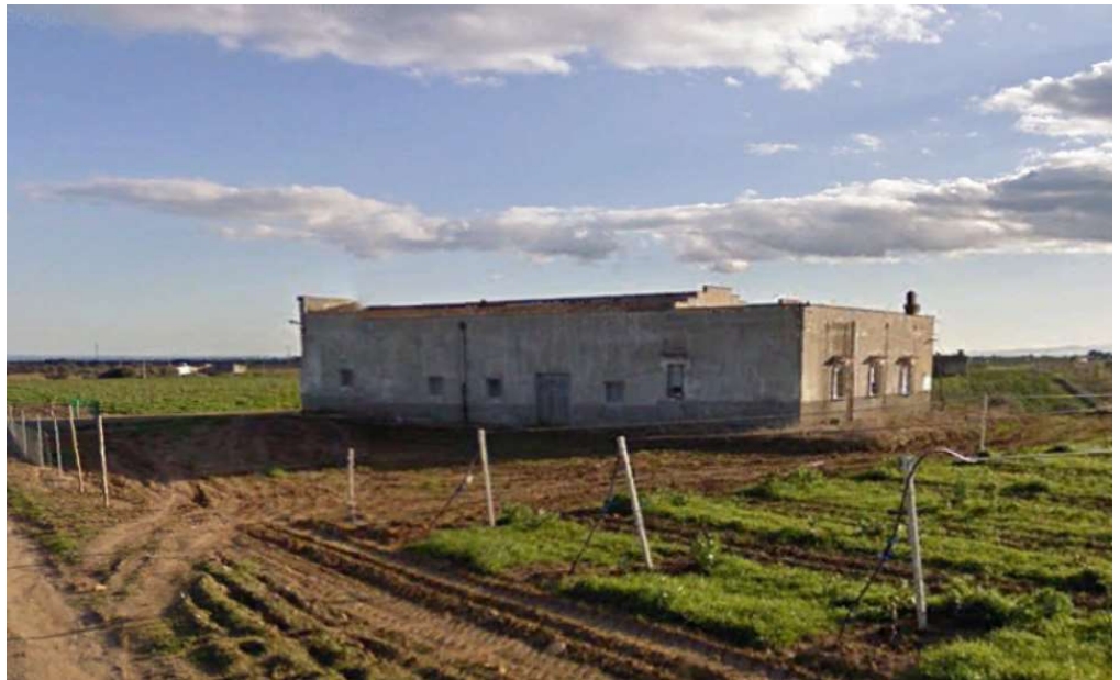
Immagine stato fabbricato
