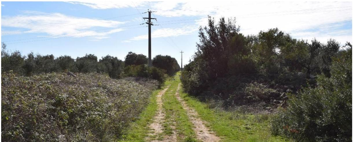
**Figura 15 – Strada locale di accesso all'aerogeneratore A04. Nella figura in alto il primo tratto della strada fotografato dalla SP 145: il tratto è ben realizzato e sarà necessario allargare la carreggiata stradale al massimo di 1 metro. Nella foto in basso è riportato l'ultimo tratto della strada in prossimità dell'aerogeneratore A03 oggetto di maggiori interventi di adeguamento.**
