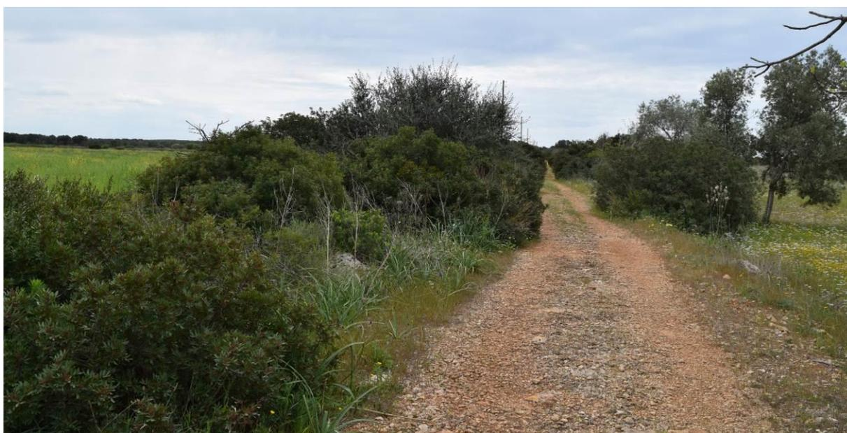
**Figura 19: stradina di accesso all'aerogeneratore A07, tratto in partenza dalla SP 219. La stradina ha necessità di essere allargata per consentire il passaggio dei mezzi di trasporto eccezionali.**
