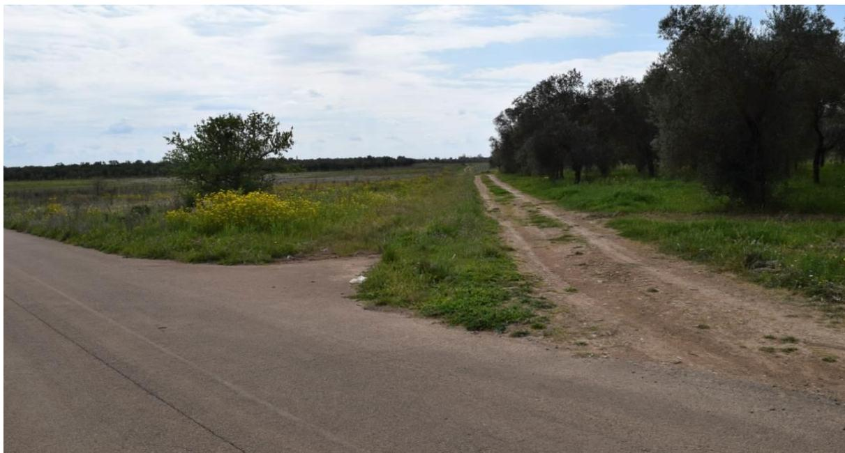
**Figura 17:** strada di accesso all'aerogeneratore A06. La strada necessita di allargamento della carreggiata mediamente di circa 1,5 metri.
