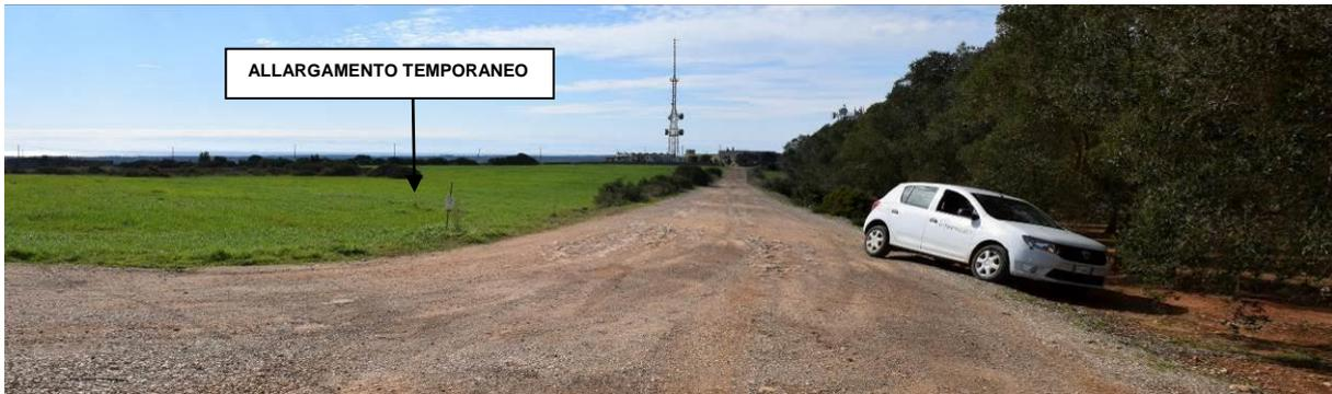
**Figura 12: Imbocco della strada di accesso all'aerogeneratore A03 che necessita di un allargamento temporaneo sulla sinistra e dell'abbattimento di pochi alberi sulla destra.**
