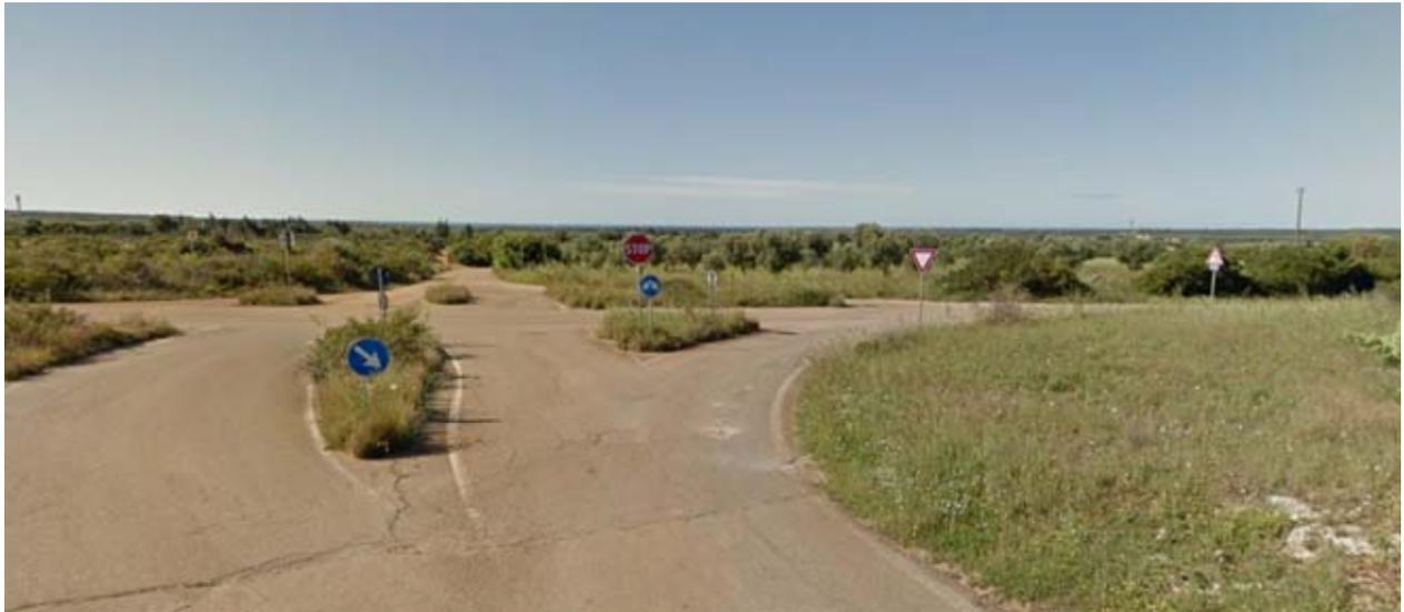
**Figura 1 - vista del tratto della SP 217 in cui è previsto un allargamento temporaneo; a destra dell'immagine è previsto un allargamento del raccordo in curva della strada esistente; l'area interessata è perimetrata come bosco ma è priva di vegetazione arbustiva e arborea.**
