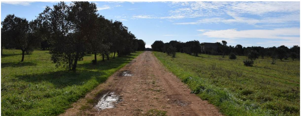
**Figura 23 – Strada locale di accesso all’aerogeneratore A05. La strada ha larghezza adeguata e necessita esclusivamente di interventi di livellamento del piano viario atti a eliminare buche e sconnessioni.**
