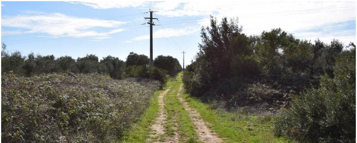
**Figura 22 – Strada locale di accesso all'aerogeneratore A04.** Nella figura in alto il primo tratto della strada fotografato dalla SP 145: il tratto è ben realizzato e sarà necessario allargare la carreggiata stradale al massimo di 1 metro. Nella foto in basso è riportato l'ultimo tratto della strada in prossimità dell'aerogeneratore A03 oggetto di maggiori interventi di adeguamento.
