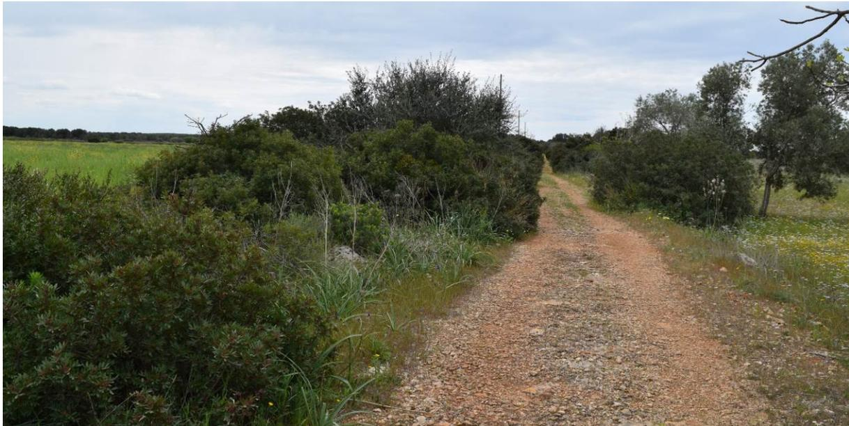
**Figura 26: stradina di accesso all'aerogeneratore A07, tratto in partenza dalla SP 219. La stradina ha necessità di essere allargata per consentire il passaggio dei mezzi di trasporto eccezionali.**
