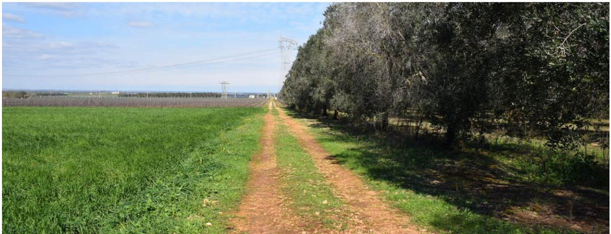
**Figura 20 –** Ultimo tratto della strada in terra battuta di accesso all'aerogeneratore A01. Come si scorge dalle fotografie, è evidente la necessità di adeguamento della viabilità esistente dal tratto in cui parte la carrareccia esistente dalla strada comunale asfaltata.
