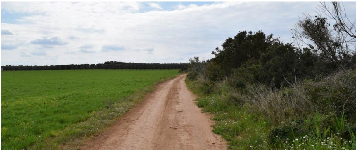
**Figura 25: stradina di accesso all'aerogeneratore A07, tratto in partenza dalla SP 145. La stradina ha necessità di essere allargata per consentire il passaggio dei mezzi di trasporto eccezionali.**
