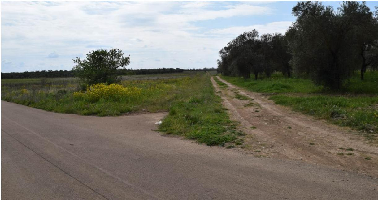
**Figura 24: strada di accesso all'aerogeneratore A06. La strada necessita di allargamento della carreggiata mediamente di circa 1,5 metri.**
