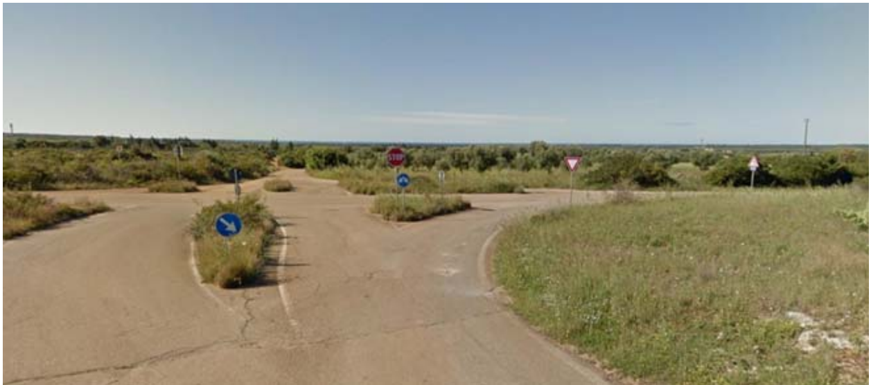
Figura 1 - vista del tratto della SP 217 in cui è previsto un allargamento temporaneo; a destra dell'immagine è previsto un allargamento del raccordo in curva della strada esistente; l'area interessata è perimetrata come bosco ma è priva di vegetazione arbustiva e arborea.
