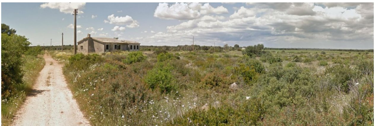
Figura 2 - vista del tratto di strada di servizio della torre A07, da adeguare e ai margini della quale è previsto un allargamento temporaneo; a destra dell'immagine è previsto un allargamento del raccordo in curva della strada esistente da adeguare in fase di cantiere; l'area interessata è perimetrata come bosco e la vegetazione arbustiva ed erbacea eventualmente rimossa o danneggiata in fase di cantiere sarà messa nuovamente a dimora a fine cantiere durante le azioni di sistemazione delle aree interessate da opere permanenti e di ripristino alle condizioni ante operam di quelle interessate da opere temporanee.
