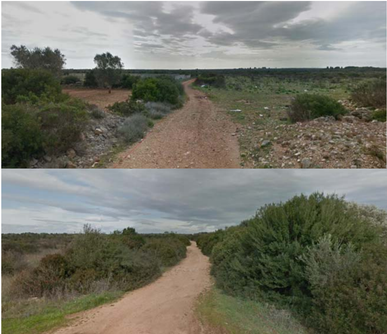
Figura 3 - vista della strada esistente in prossimità della Torre A04; la strada esistente sarà in parte adeguata e consolidata senza opere di impermeabilizzazione; lungo la stessa sarà interrato il cavidotto; le aree a margine sono perimetrate come bosco o comunque le opere ricadono in fascia di rispetto; per la realizzazione delle stesse, saranno operati minimi tagli di rami e non si prevedono eradicazioni di arbusti. Le specie danneggiate o rimosse anche accidentalmente, a fine cantiere saranno rimesse a dimora in fase di sistemazione e ripristino delle aree interessate dalle opere.
