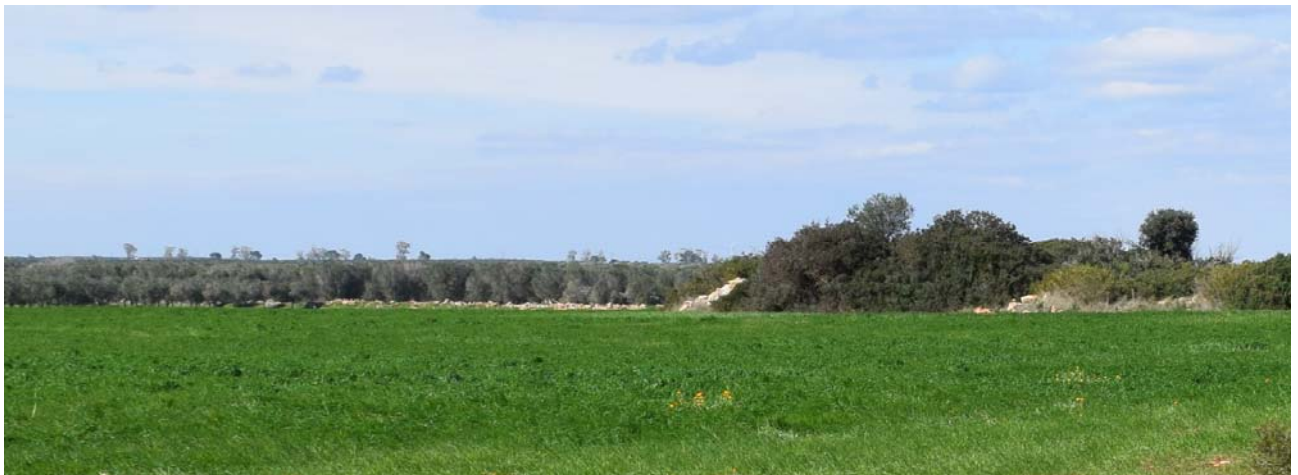
Figura 1: muretto sito a nord dell'aerogeneratore A03 completamente diruto e invaso da vegetazione.
