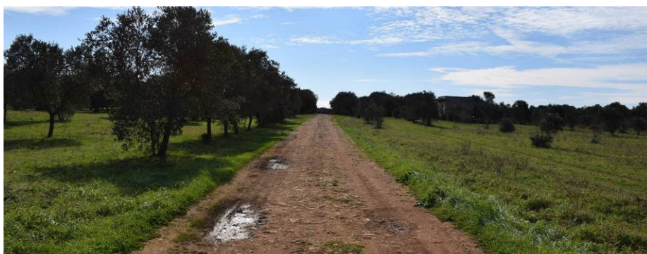
Figura 3 –Strada esistente da adeguare, lungo la quale verrà posato il cavidotto, che permette l’accesso alla torre A05 dalla SP145 nel tratto perimetrato come area BP
