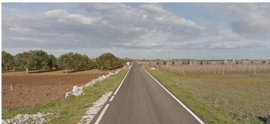
Figura 5 –Strada lungo la quale verrà posato il cavidotto nei pressi della stazione RTN nel tratto perimetrato come area AP e MP
