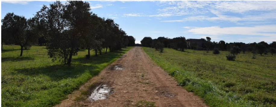
Figura 3 –Strada esistente da adeguare, lungo la quale verrà posato il cavidotto, che permette l’accesso alla torre A05 dalla SP145 nel tratto perimetrato come area BP
