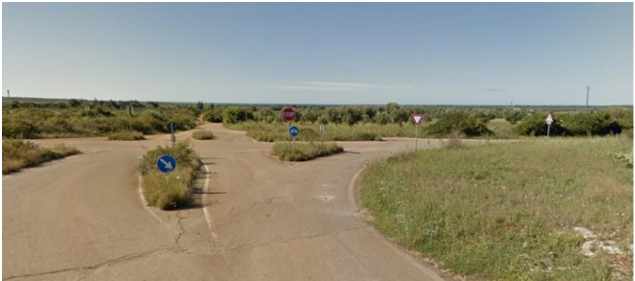
Figura 10 - vista del tratto della SP 217 in cui è previsto un allargamento temporaneo; a destra dell'immagine è previsto un allargamento del raccordo in curva della strada esistente; l'area interessata è perimetrata come bosco ma è priva di vegetazione arbustiva e arborea.
