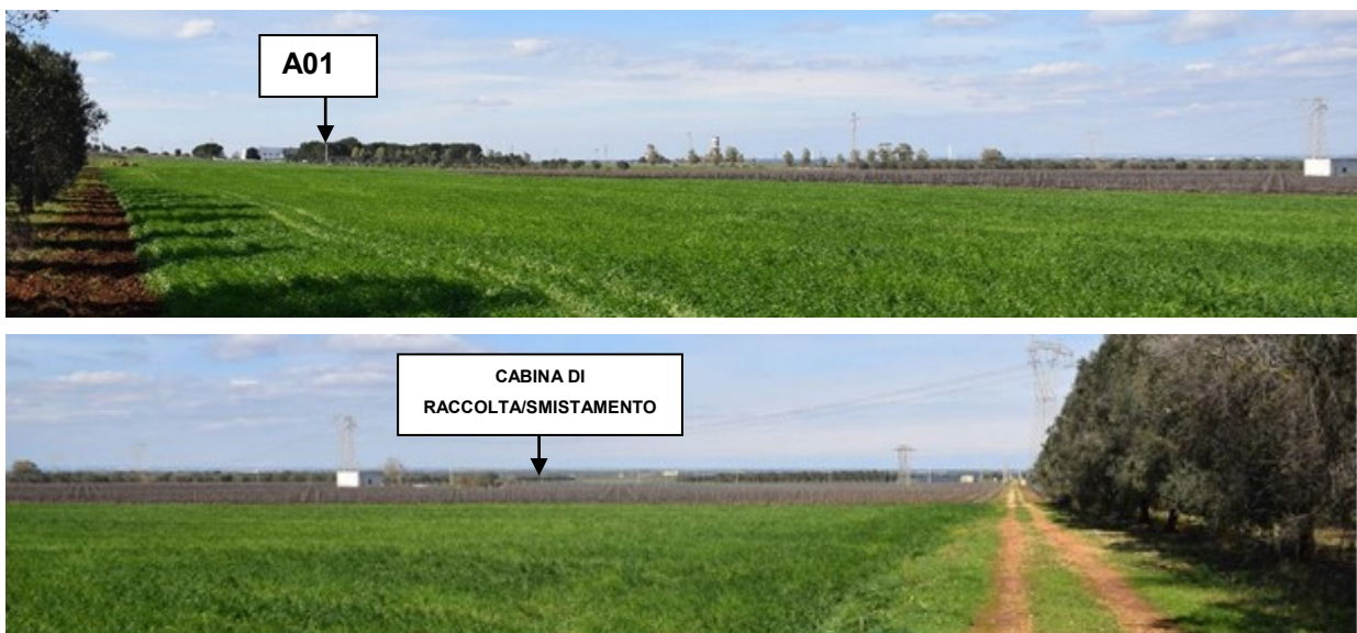
Figura 2: Foto in alto: vista dell'area interessata dall'ubicazione dell'aerogeneratore A01. Foto in basso: vista della strada in terra battuta, di accesso all'aerogeneratore A01. Per le necessità dovute al transito di mezzi di trasporto delle strutture costituenti gli aerogeneratori, la stradina sterrata sarà adeguata. In prossimità di tale strada, è prevista la realizzazione della cabina di raccolta/smistamento.
