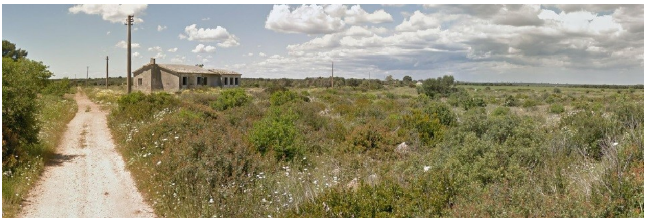
Figura 11 - vista del tratto di strada di servizio della torre A07, da adeguare e ai margini della quale è previsto un allargamento temporaneo; a destra dell'immagine è previsto un allargamento del raccordo in curva della strada esistente da adeguare in fase di cantiere; l'area interessata è perimetrata come bosco e la vegetazione arbustiva ed erbacea eventualmente rimossa o danneggiata in fase di cantiere sarà messa nuovamente a dimora a fine cantiere durante le azioni di sistemazione delle aree interessate da opere permanenti e di ripristino alle condizioni ante operam di quelle interessate da opere temporanee.
