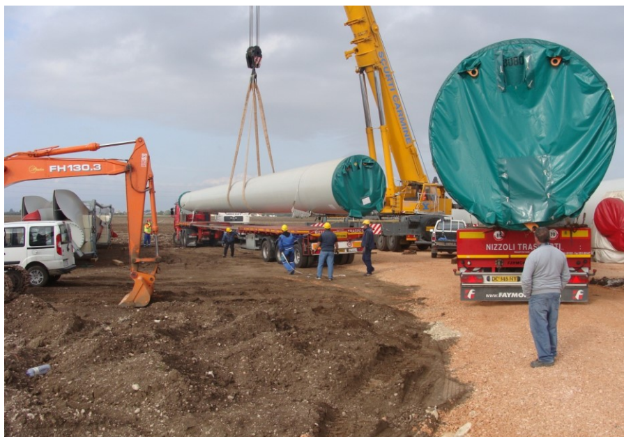
Figura 6: elementi torre smontata da trasportare
