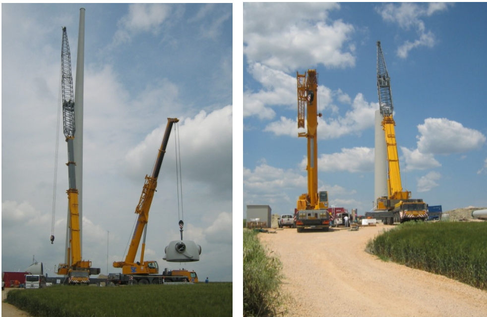
Figura 3: smontaggio navicella
