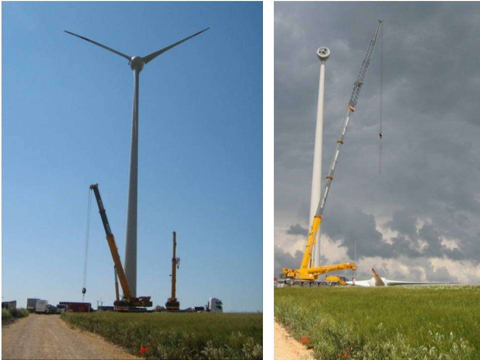
Figura 2: rimozione eliche e mozzo
