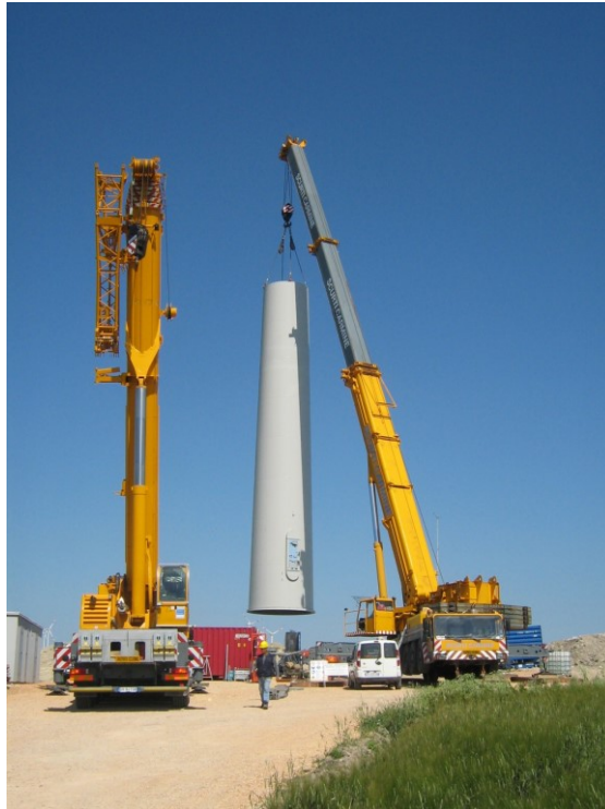
Figura 5: elemento torre smontata da trasportare
