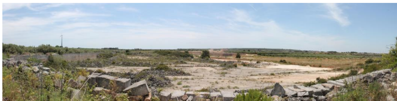
Figura 1.8 Vista di una cava abbandonata in uscita da Avetrana lungo la SP 145
