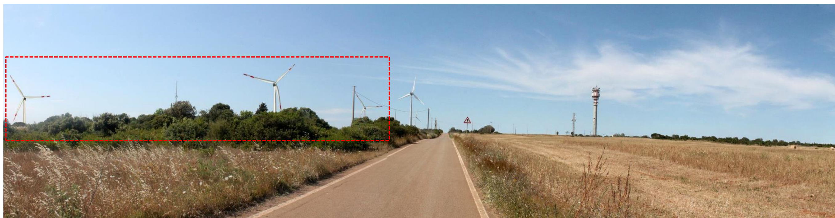
Figura 6.25 _ PAN 17 _ Confronto tra stato di fatto (in alto) e progetto _ Vista a circa 1 km di distanza dagli aerogeneratori in progetto (nel riquadro rosso)
