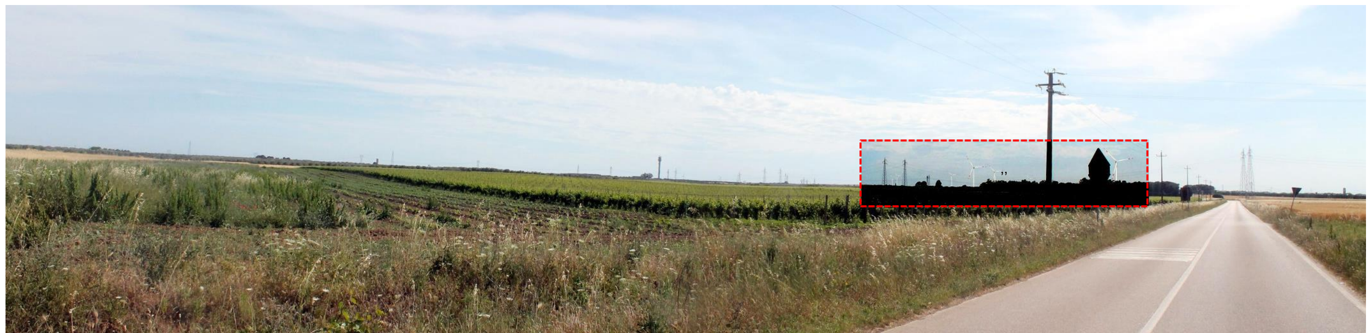
Figura 6.21 _ PAN 13 _ Confronto tra stato di fatto (in alto) e progetto _ Vista a circa 2,5 km di distanza dagli aerogeneratori in progetto (nel riquadro rosso con maschera di evidenziazione)
