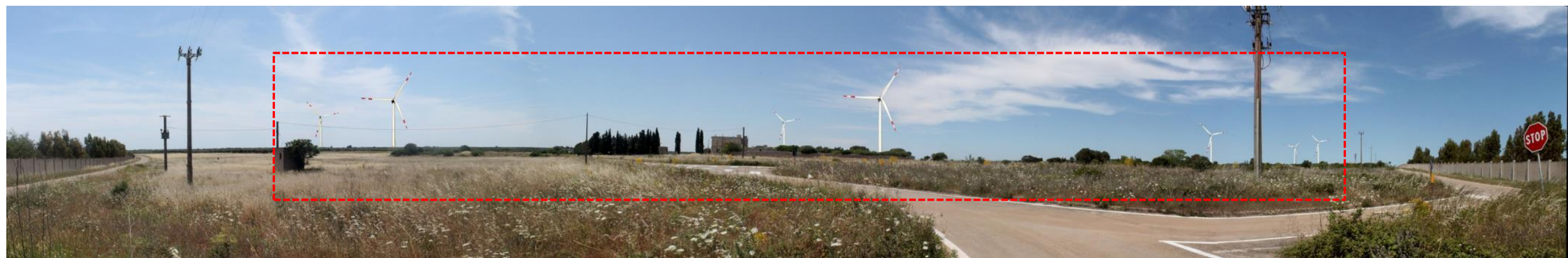
Figura 6.30 _ PAN 22_ Confronto tra stato di fatto (in alto) e progetto _ Vista a circa 900 m di distanza dagli aerogeneratori in progetto (nel riquadro rosso)
