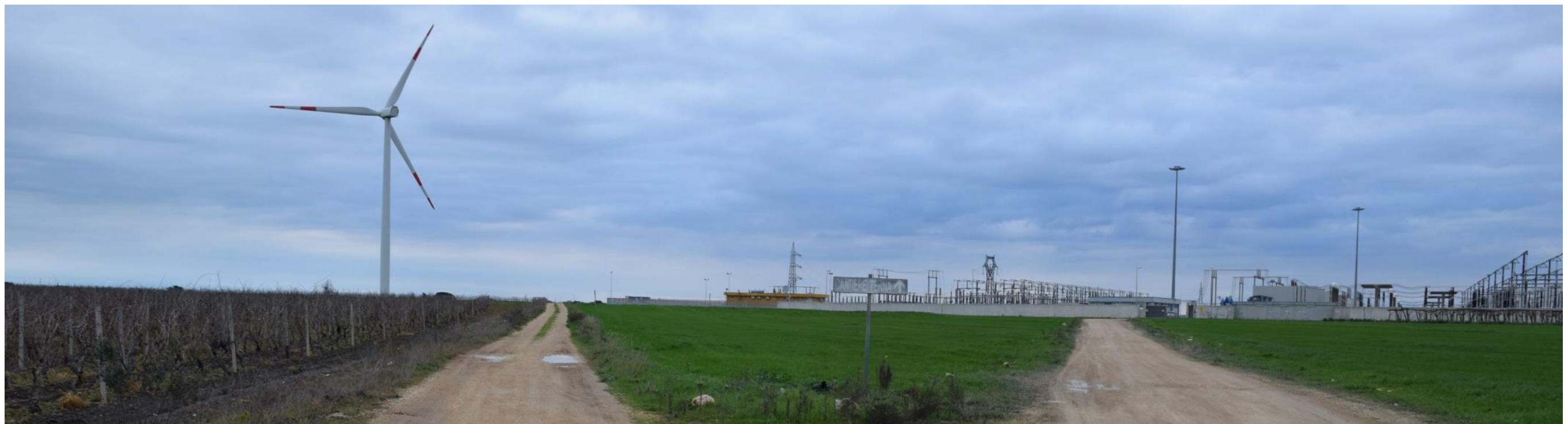
Figura 4.14 _ Viste della Stazione Elettrica TERNA 380/150 kV "Erchie" a cui si connette l'impianto in progetto e gli aerogeneratori limitrofi.
