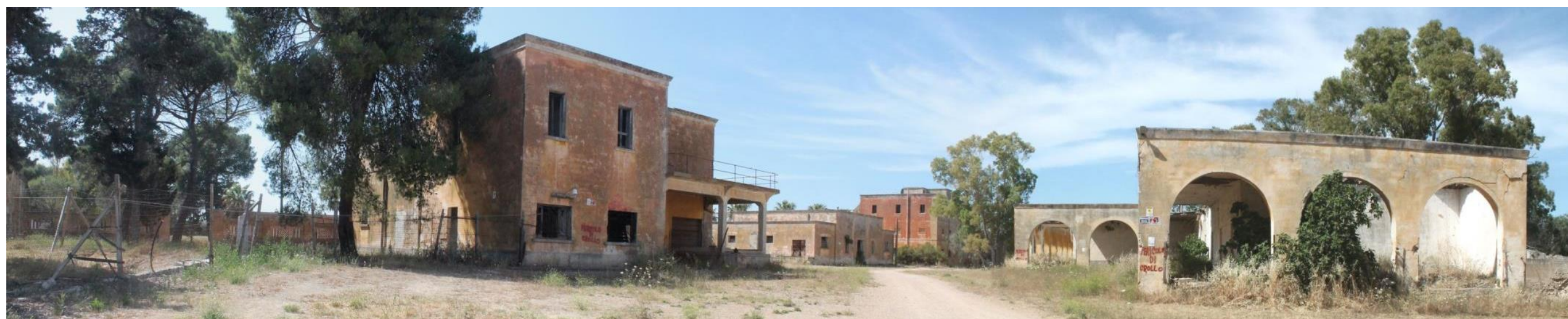
Figura 4.11 _ Situazioni di degrado e abbandono troppo spesso frequenti nell'area circostante la centrale eolica; cava dismessa (in alto), manufatti incompiuti, e lo stato di degrado e abbandono del Borgo Monteruga.
