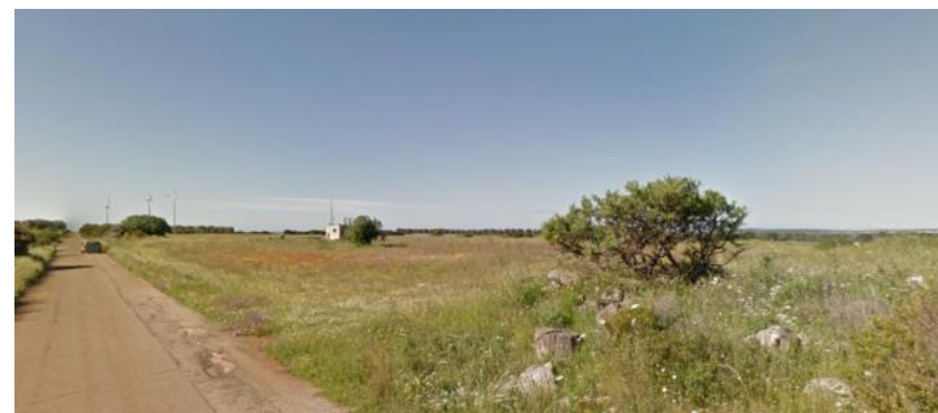
Figura 3.4 della SP 217 in corrispondenza dell'innesto della strada di accesso alla Torre A02;
