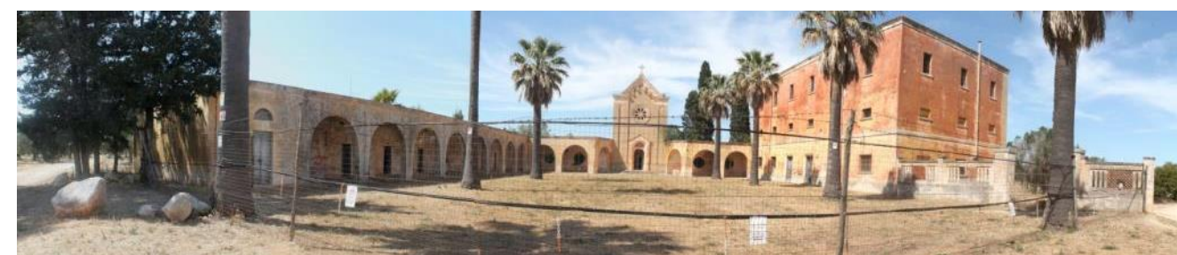
Figura 1.15 Vista del borgo rurale della Riforma Agraria di Monteruga, in totale stato di abbandono.
