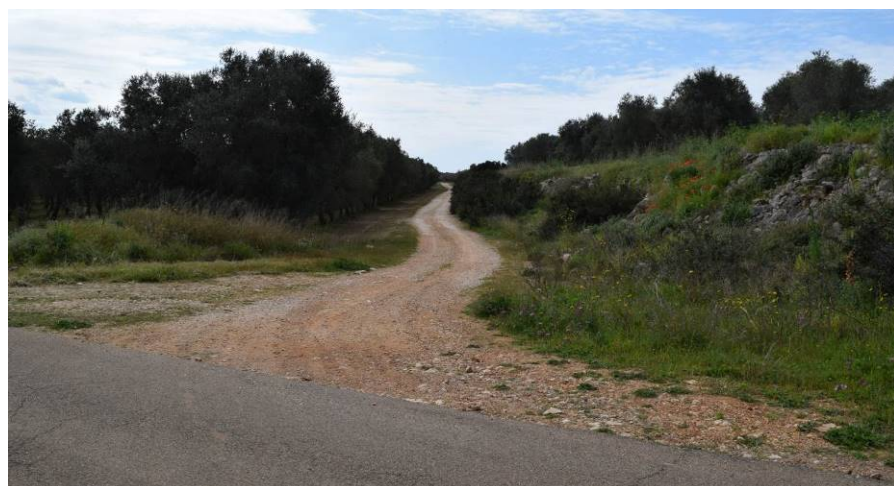
Figura 10: stradina di accesso all'aerogeneratore A07, tratto in partenza dalla SP 219. La stradina ha necessità di essere allargata per consentire il passaggio dei mezzi di trasporto eccezionali.
