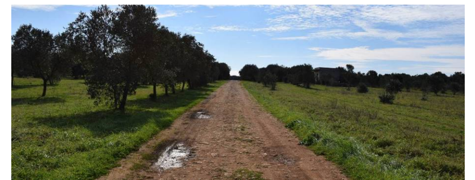
Figura 7 – Strada locale di accesso all'aerogeneratore A05. La strada ha larghezza adeguata e necessita esclusivamente di interventi di livellamento del piano viario atti a eliminare buche e sconnessioni.
