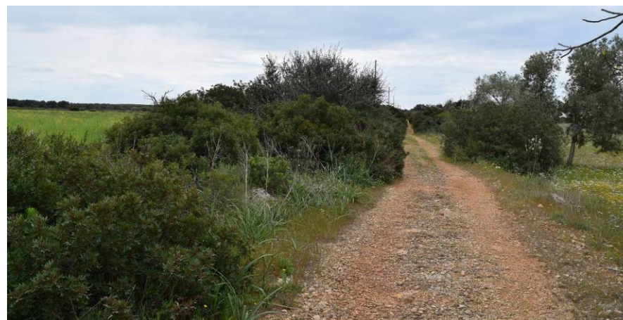
Figura 10: stradina di accesso all'aerogeneratore A07, tratto in partenza dalla SP 219. La stradina ha necessità di essere allargata per consentire il passaggio dei mezzi di trasporto eccezionali.
