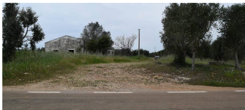
Figura 18 – Imbocco dalla SP219 della strada di accesso al sito di ubicazione dell'aerogeneratore A07 che necessita di allargamento temporaneo.
