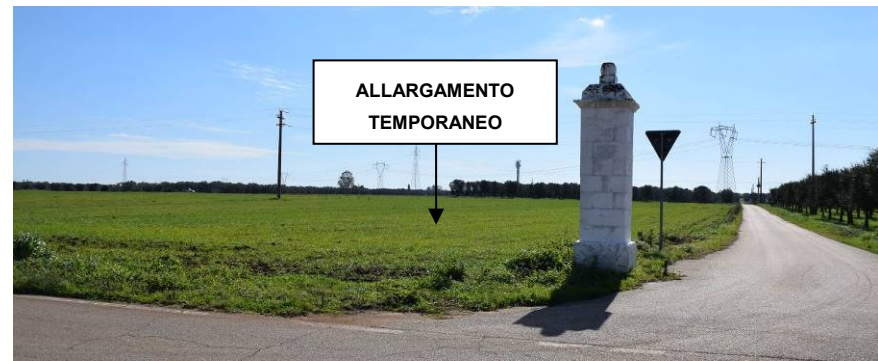
Figura 13 - Incrocio tra SP107 e strada di accesso all'aerogeneratore A01, che necessita di allargamento temporaneo.
