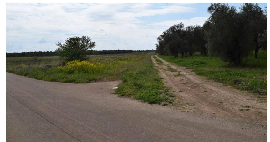
Figura 8: strada di accesso all'aerogeneratore A06. La strada necessita di allargamento della carreggiata mediamente di circa 1,5 metri.
