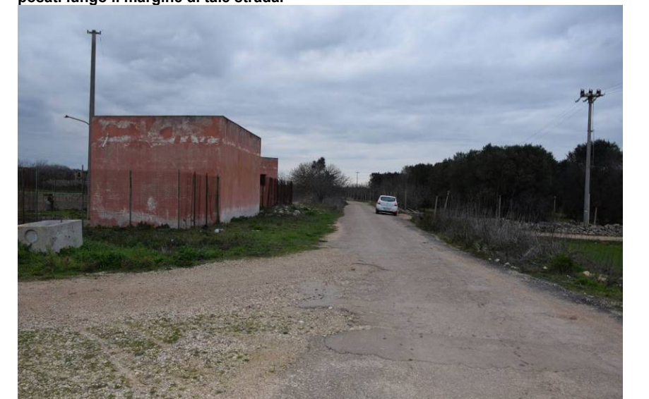
Figura 26- Tratto di strada comunale "Frassanito". I cavidotti saranno posati lungo il margine di tale strada.
