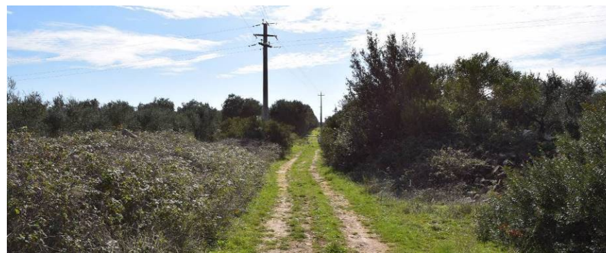
Figura 6 – Strada locale di accesso all'aerogeneratore A04. Nella figura in alto il primo tratto della strada fotografato dalla SP 145: il tratto è ben realizzato e sarà necessario allargare la carreggiata stradale al massimo di 1 metro. Nella foto in basso è riportato l'ultimo tratto della strada in prossimità dell'aerogeneratore A03 oggetto di maggiori interventi di adeguamento.
