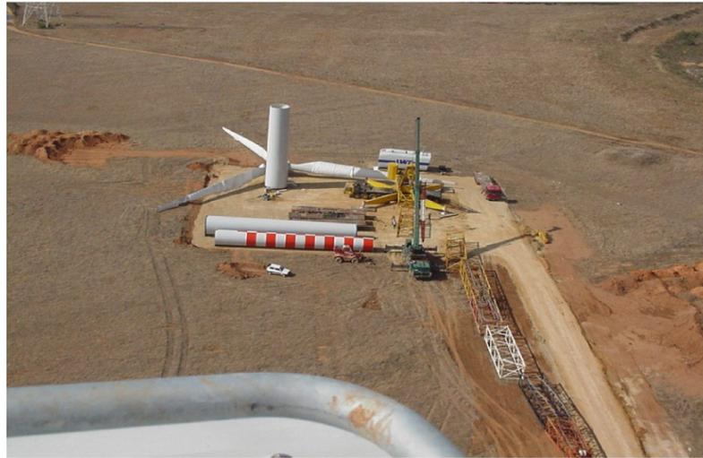
Figura 9 –Piazzola per il montaggio dell'aerogeneratore
