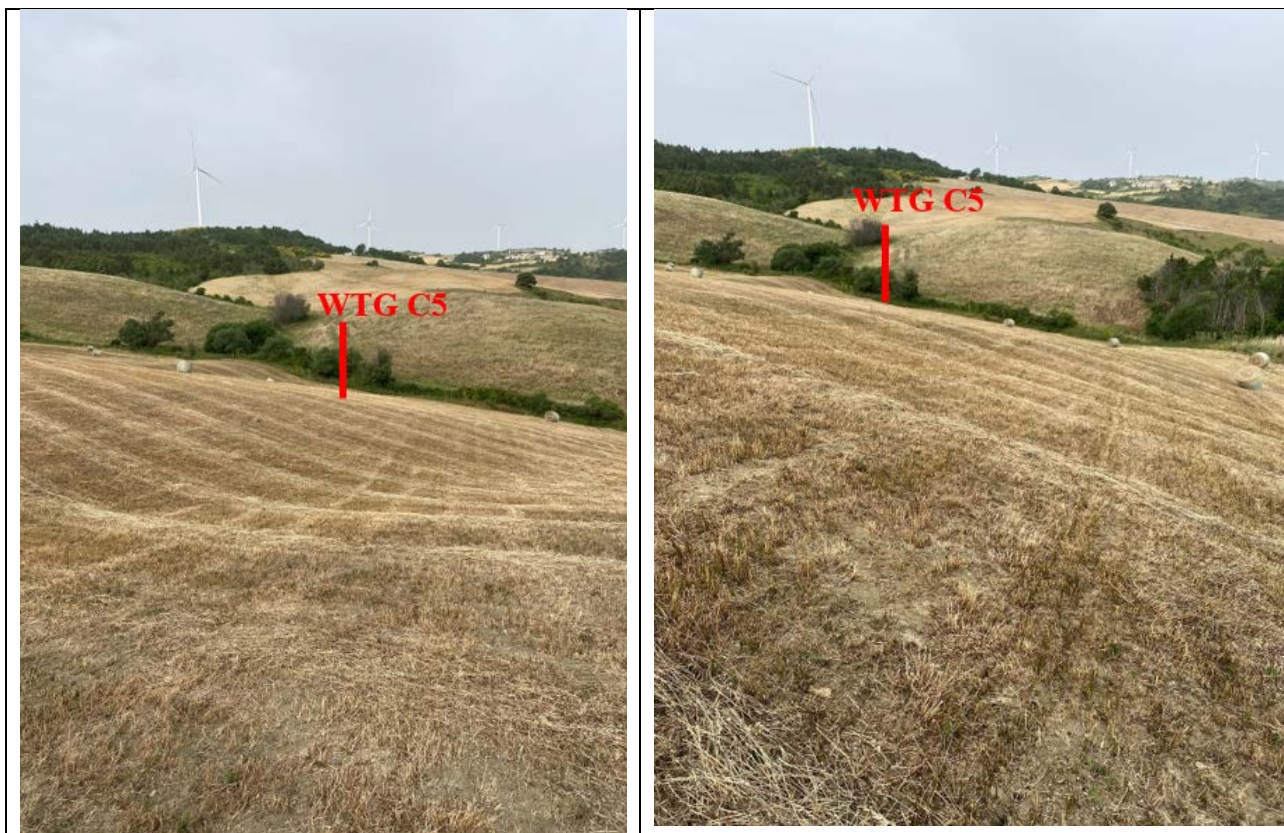
Versante collinare occidentale "Aia del Piano" con indicazione area di sedime che ospiterà l' aerogeneratore WTG C5
