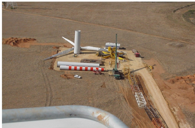
Figura 2 – Piazzola per il montaggio dell'aerogeneratore
