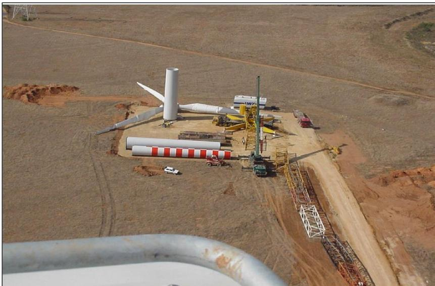
Foto 1. Piazzola per il montaggio dell'aerogeneratore
