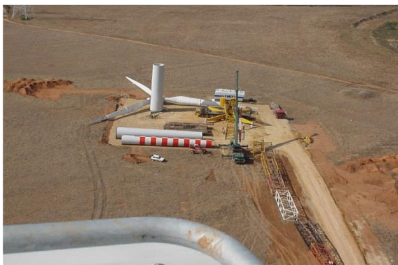
Figura 24 – Piazzola per il montaggio dell'aerogeneratore
