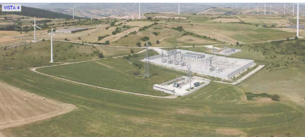
Figura 44 – Foto stato di fatto
