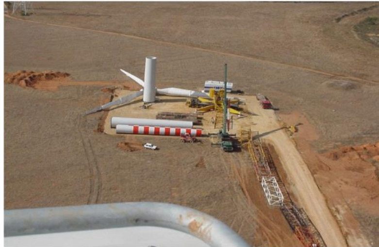
Figura 12 – Piazzola per il montaggio dell'aerogeneratore
