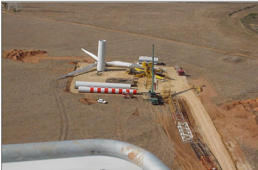
Foto 1. Piazzola per il montaggio dell'aerogeneratore
