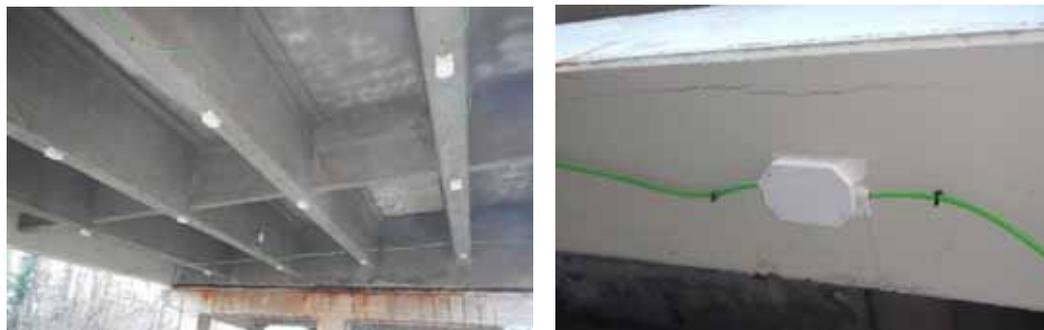
Figura 24. Sensori installati su una struttura
