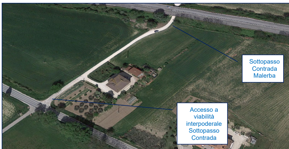
Figura 11.7 Accesso alla viabilità interpodereale del Sottopasso Contrada Malerba (vista da S.P.28 Fonte Google Street view).
