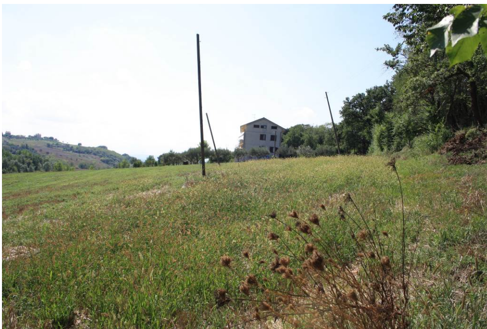
Figura 6.15 Area a valle della Via Fontescodella - pali inclinati - (prog. di progetto circa 4+700)
