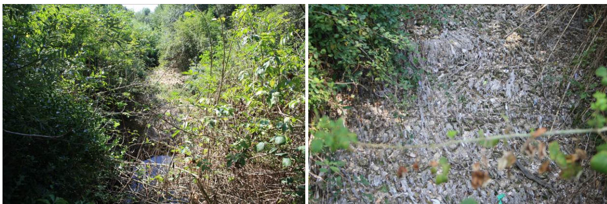
Figura 6.27 Fosso Valteja – incisione valliva e controllo dell'erosione tramite gabbionate in alveo - (fuori tracciato)
