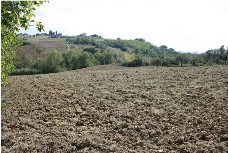
Figura 4.8 Area a valle della Via Fontescodella – Settore di valle, ondulazioni sulla superficie - (prog. di progetto circa 4+00)
