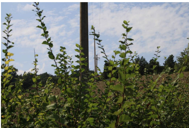
Figura 4.7 Area a valle della Via Fontescodella – Settore di valle, leggere inclinazioni dei pali della luce - (prog. circa 3+700)
