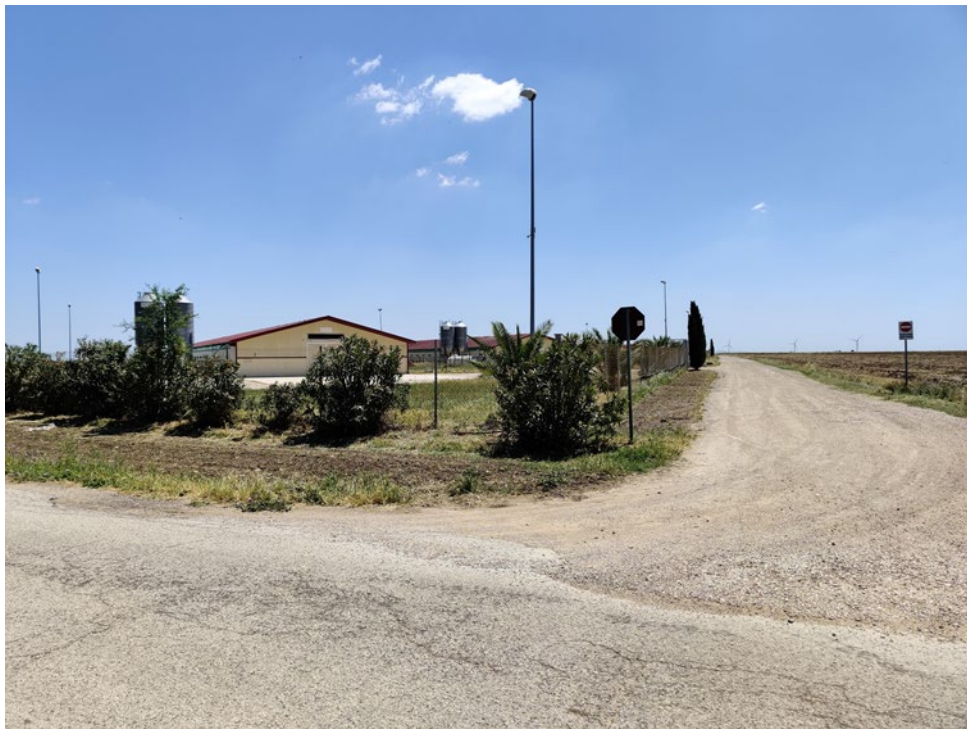
Figura 2-2: Vista in direzione delle turbine C-01, C-02, C-03 e C-04 dalla SP82
