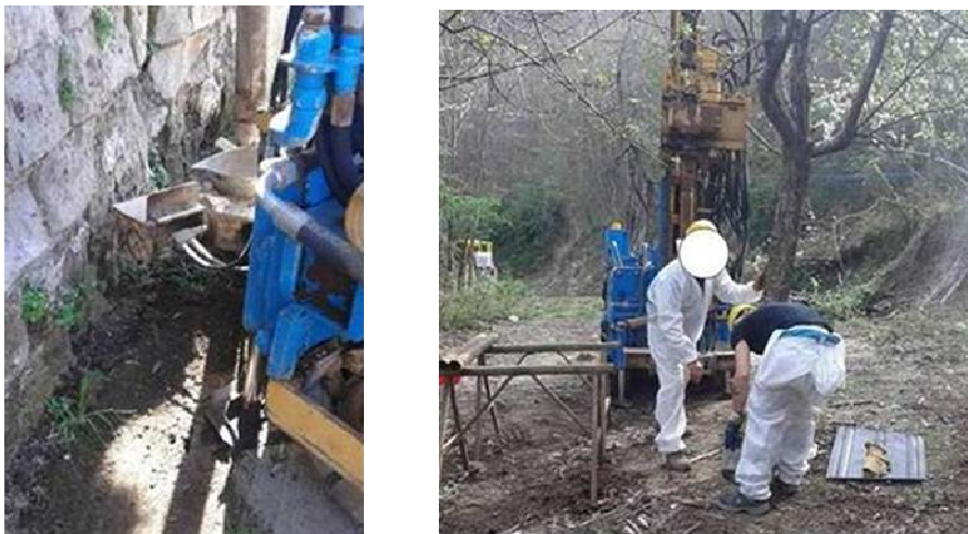
Figura 10-3: Sondaggio effettuato mediante perforazione a carotaggio.
