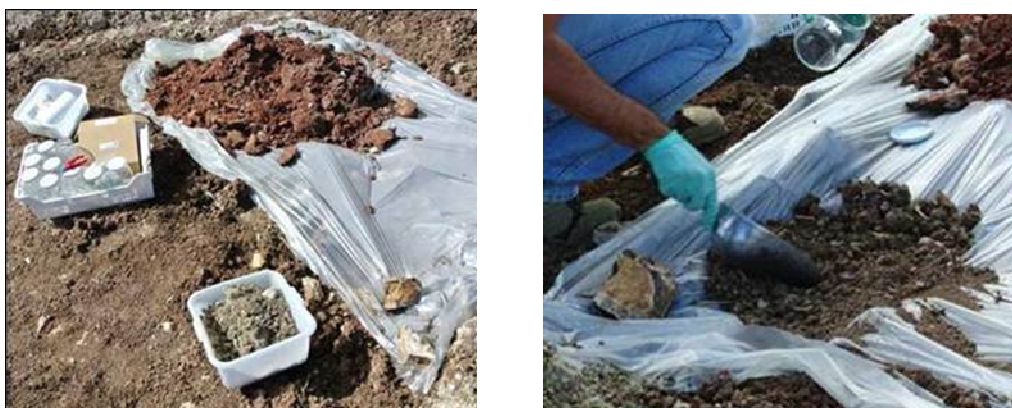
Figura 10-5: Deposito materiale scavato e Campionamento terre
