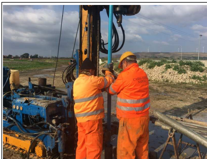
Installazione piezometro a tubo aperto
