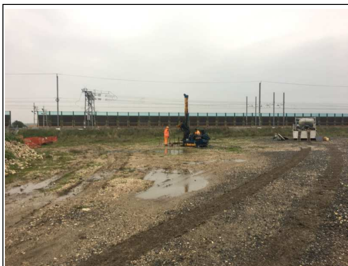
Postazione Sondaggio S1
