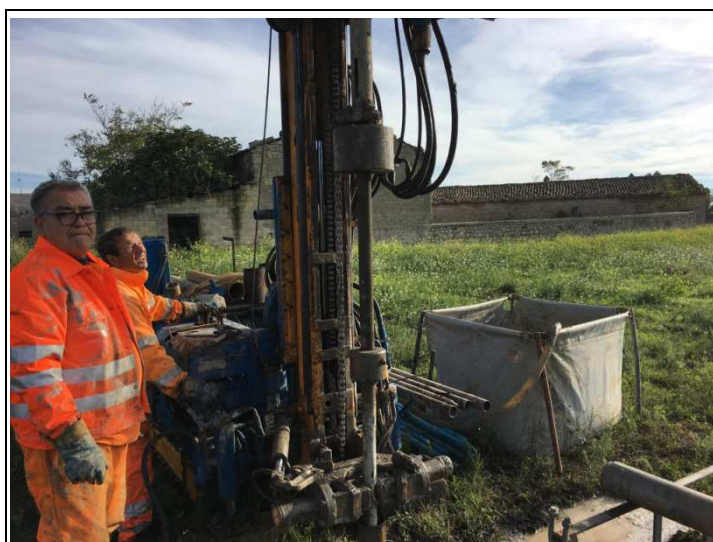
Esecuzione prova S.P.T.
