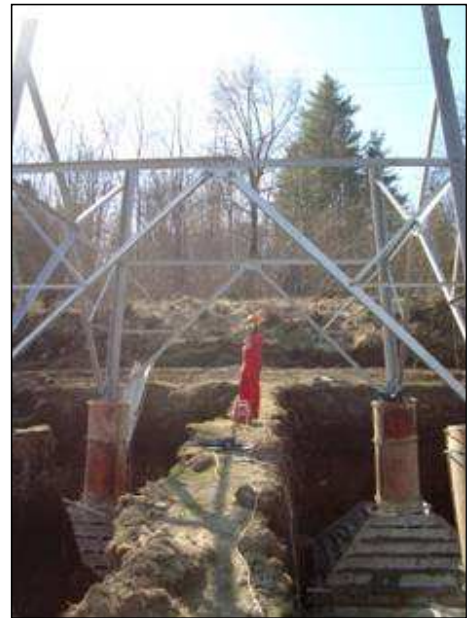
Figura 6.5-5: Esempio di realizzazione del piede di fondazione
