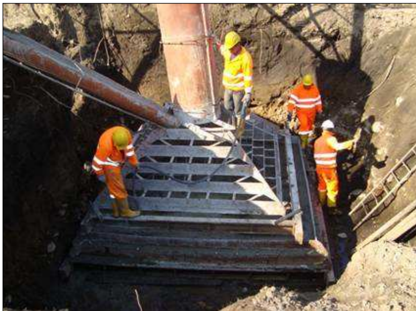
Figura 6.5-5: Esempio di realizzazione del piede di fondazione
