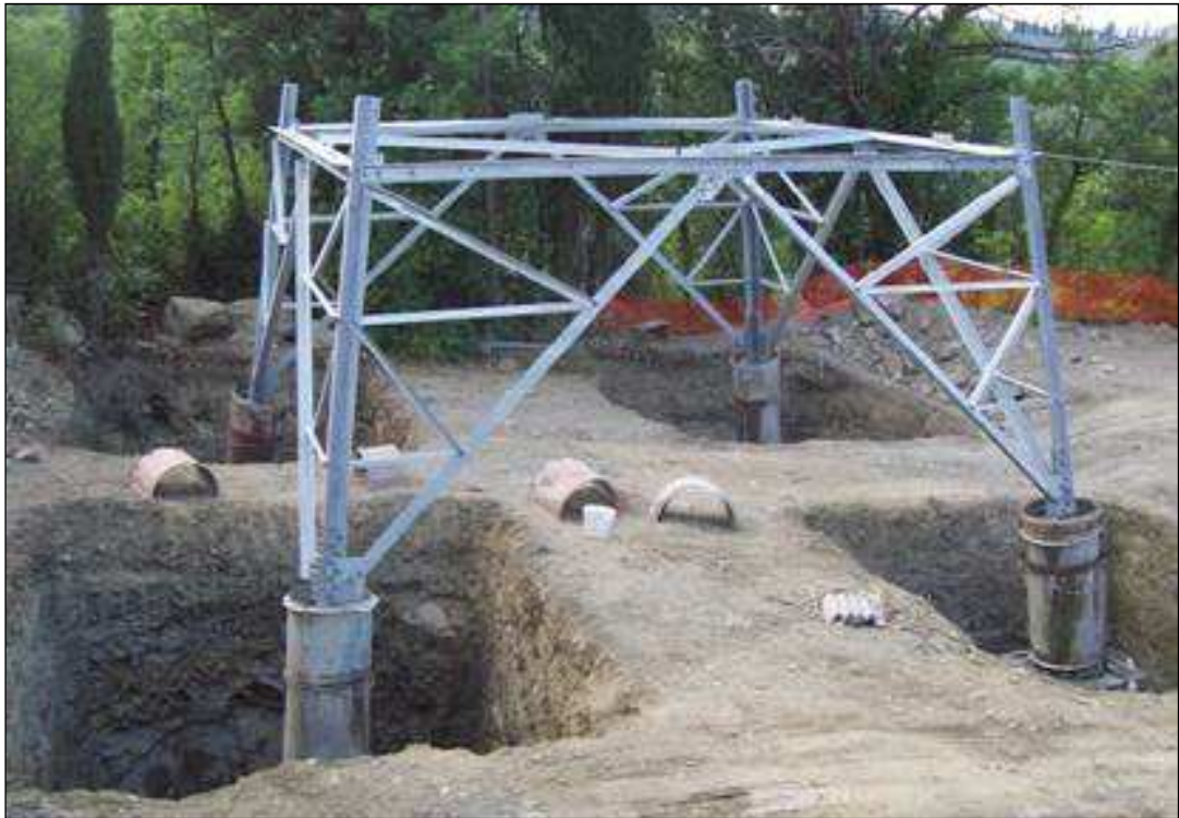
Figura 6.5-4: Esempio di fondazione di un sostegno
