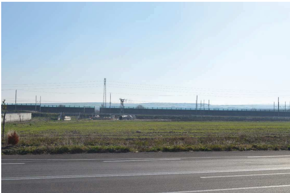
Foto 3: Vista panoramica del rilevato ferroviario adiacente dell'area in cui sorgerà la nuova S/E di Bovino.
