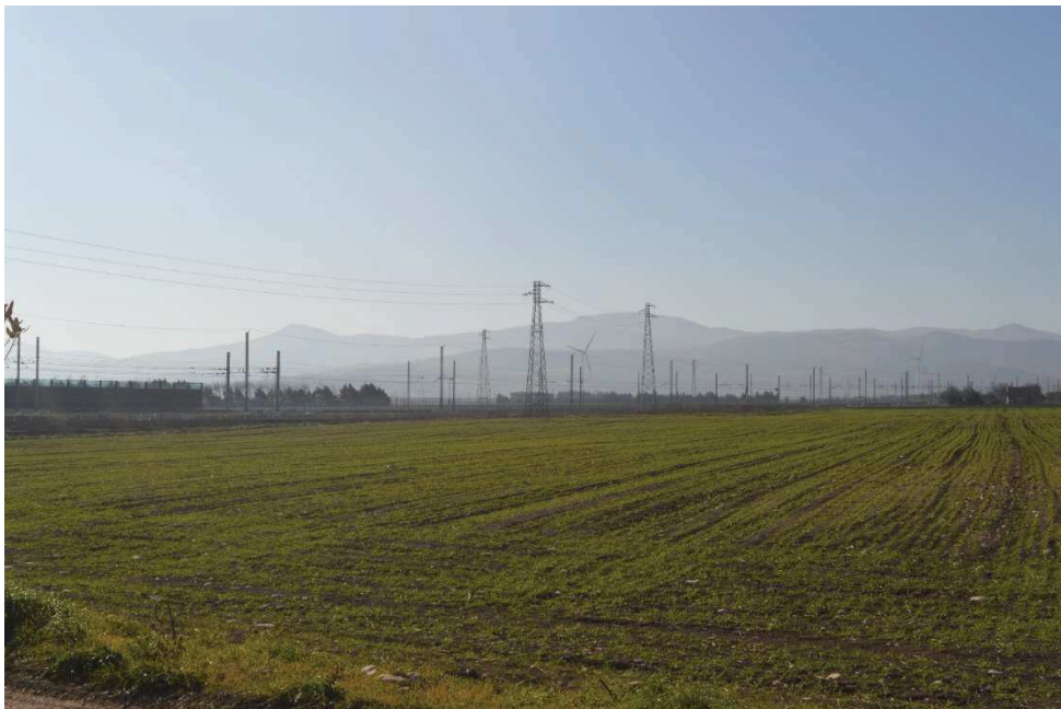
Foto 1: Vista panoramica dell'area in cui sorgerà la nuova S/E di Bovino.
