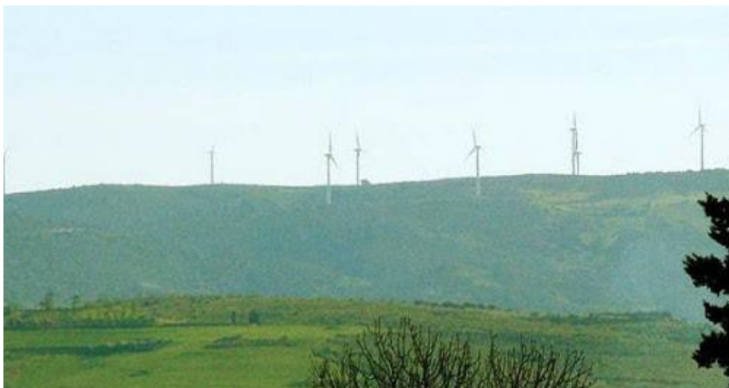
Parco eolico ubicato nella stessa area
