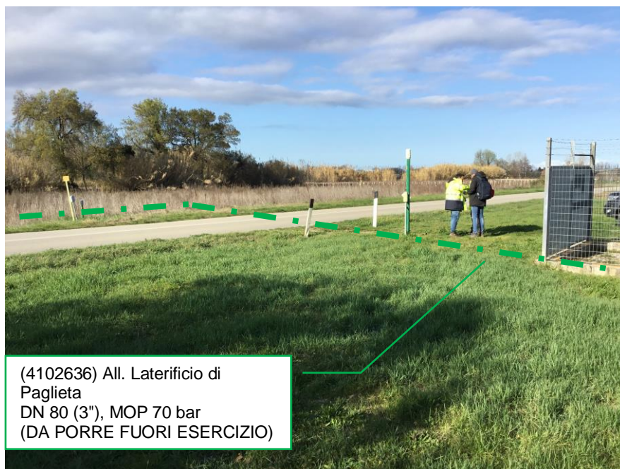
Foto n.2 – Vista con metanodotto da porre fuori esercizio
