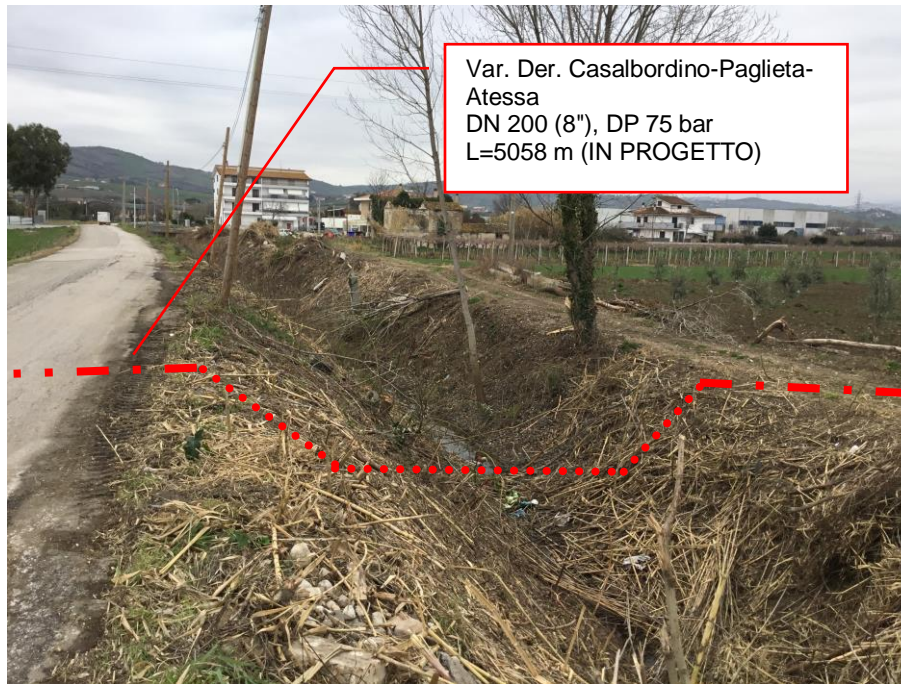
Foto n.13 – Var. Der. Casalbordino-Paglieta-Atessa DN 200 (8"), DP 75 bar (in progetto) con attraversamento fosso
