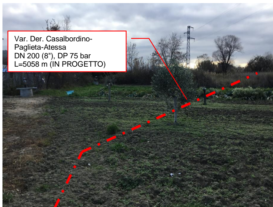
Foto n.4 – Var. Der. Casalbordino-Paglieta-Atessa DN 200 (8"), DP 75 bar (in progetto)
