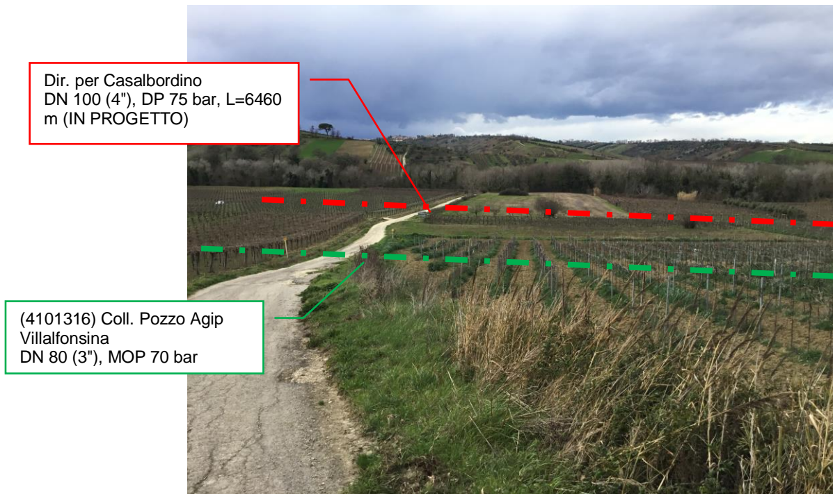
Foto n.9 – Panoramica metanodotti in progetto e metanodotto da porre fuori esercizio
