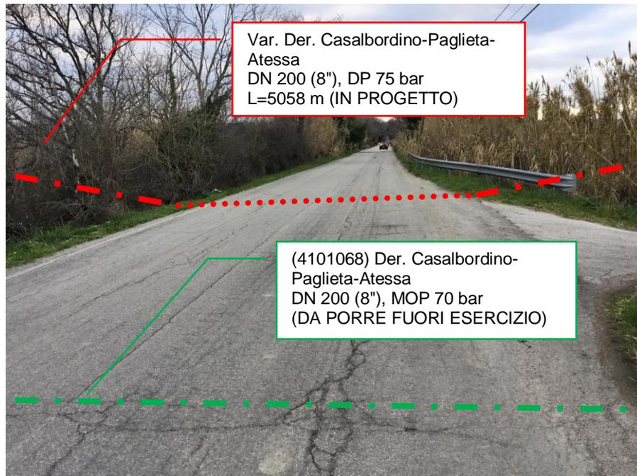
Foto n.7 – Vista metanodotto in progetto con attraversamento strada e metanodotto da porre fuori esercizio
