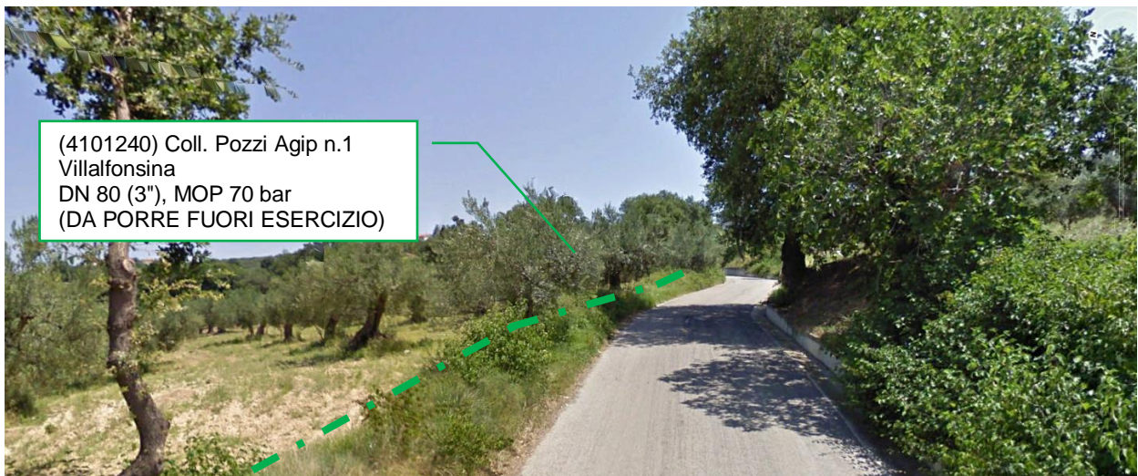
Foto n.2 – Percorrenza metanodotto da porre fuori esercizio lungo strada
