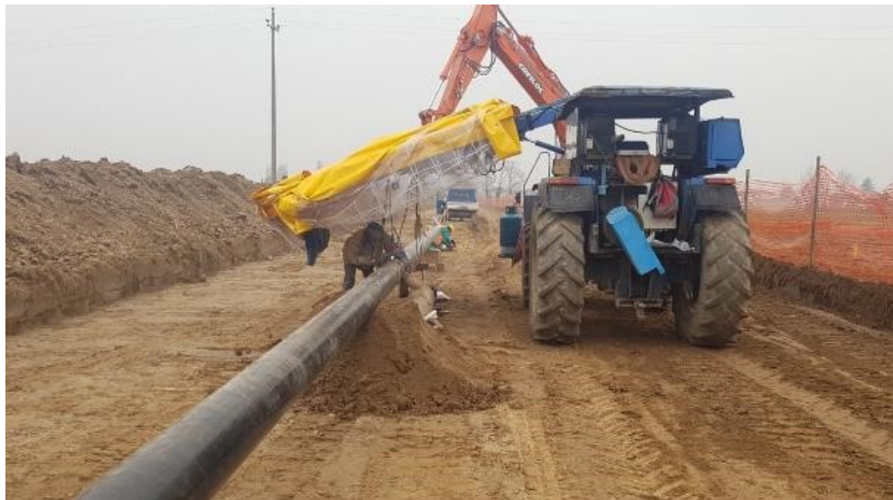
Figura 9-6 – Fase di saldatura manuale
