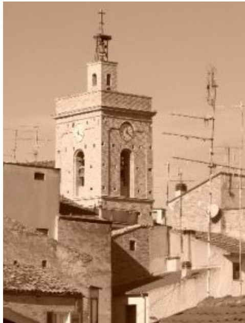
Figura 1-8: Veduta storica della torre campanaria di Paglieta (CH)
