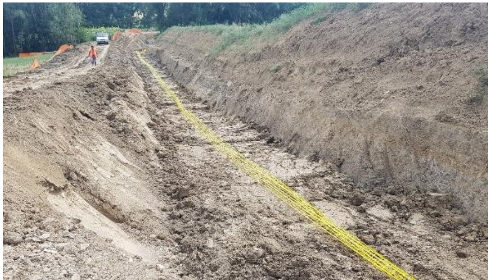
Figura 9-10 – Rinterro della condotta
