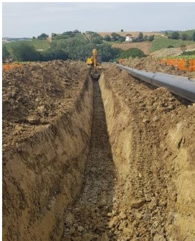
Figura 9-7 – Scavo della trincea
