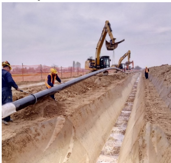
Figura 9-9 – Posa della condotta
