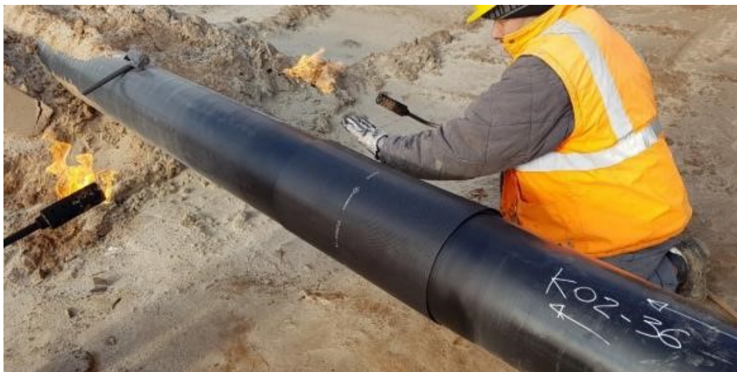
Figura 9-8 – Applicazione manuale di una fascia termo-restringente su giunto saldatura
