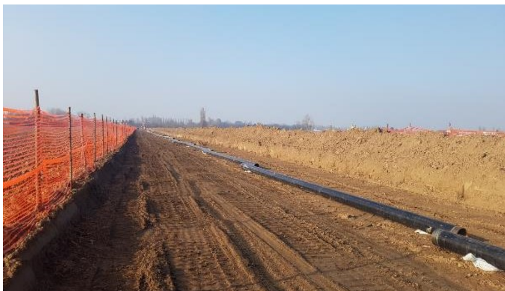
Figura 9-5 – Sfilamento delle tubazioni di linea
