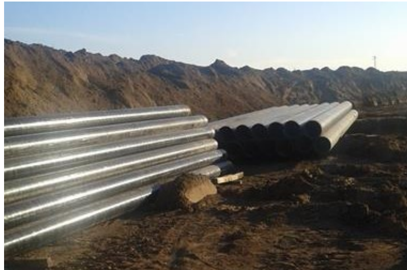
Figura 9-1 – Piazzola di accatastamento tubazioni
