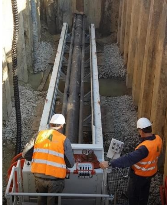
Figura 9-14 – Esecuzione di trivellazione spingitubo
