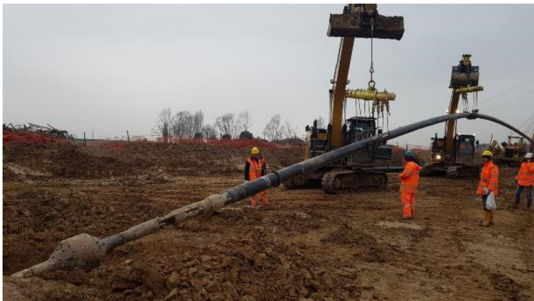
Figura 9-18 – Esempio di operazione di varo della TOC
