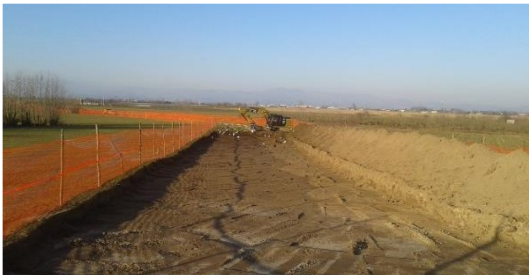
Figura 9-2 – Foto di apertura della pista di lavoro
