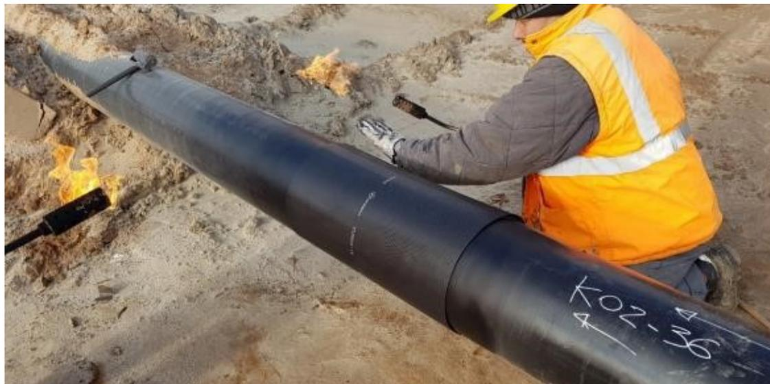
Ultimata la verifica della perfetta integrità del rivestimento, la colonna saldata sarà sollevata e posata nello scavo con l'impiego di trattori posatubi detti sideboom.
