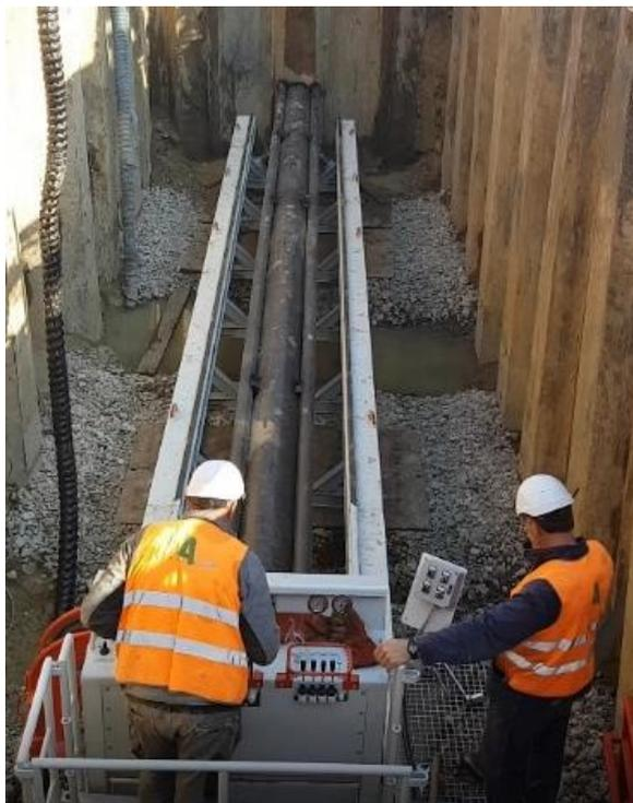
Una volta completate le operazioni di inserimento, alle estremità del tubo di protezione vengono applicati i tappi di chiusura con fasce termorestringenti.
