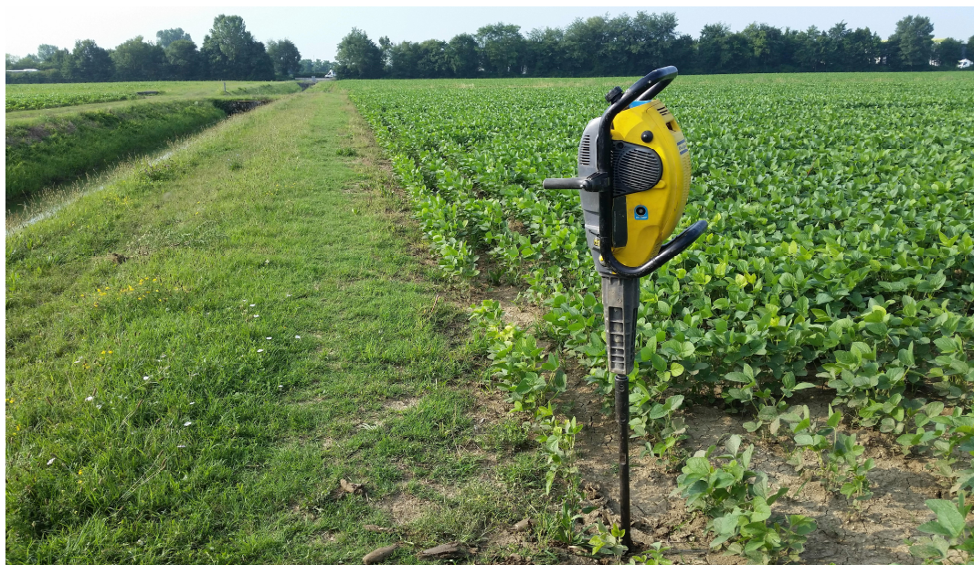
Fig. 3.2.B - Campionatore utilizzato per l'esecuzione del sondaggio ambientale per la caratterizzazione di terre e rocce da scavo
