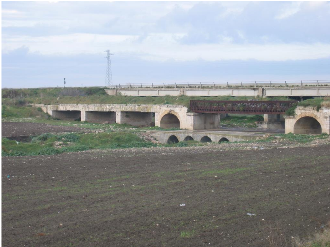
Figura 4.1 – vista dell’attraversamento presa da valle, con in primo piano il guado ed il ponte relitto, mentre a tergo è visibile l’impalcato del ponte della strada attuale
