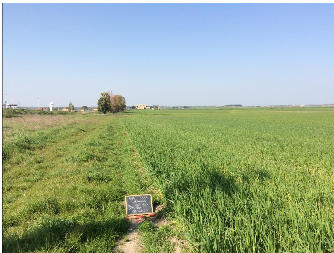
Figura 16. S.S. 89, lato nord, km 181+600
