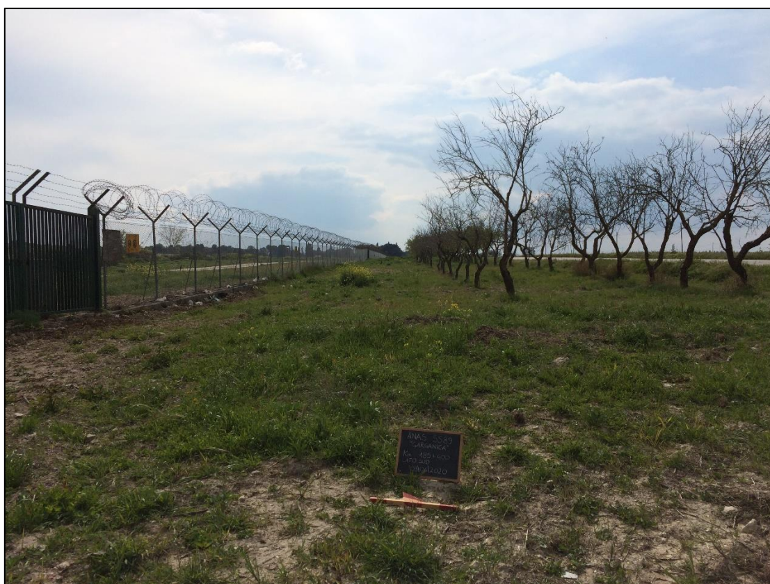
Figura 15. S.S. 89, lato sud, km 185+400
