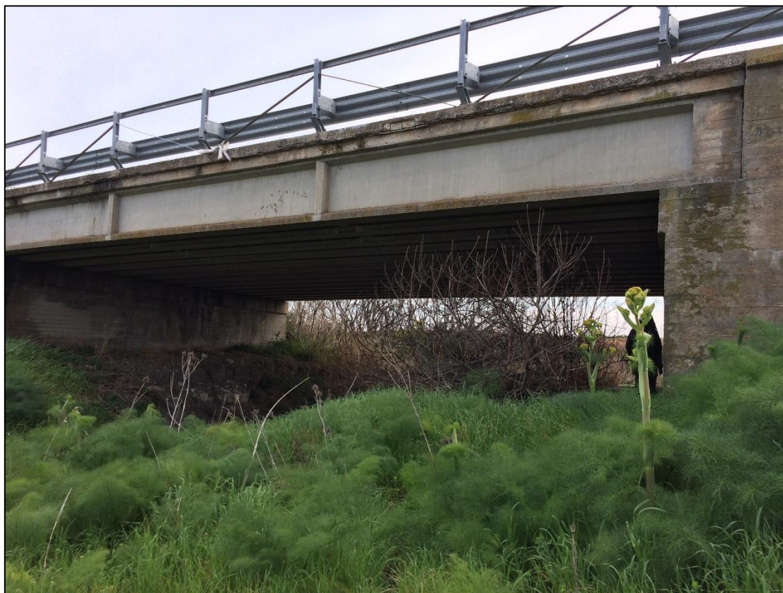
Figura 8. Ponte sul torrente Candelaro, lato nord
