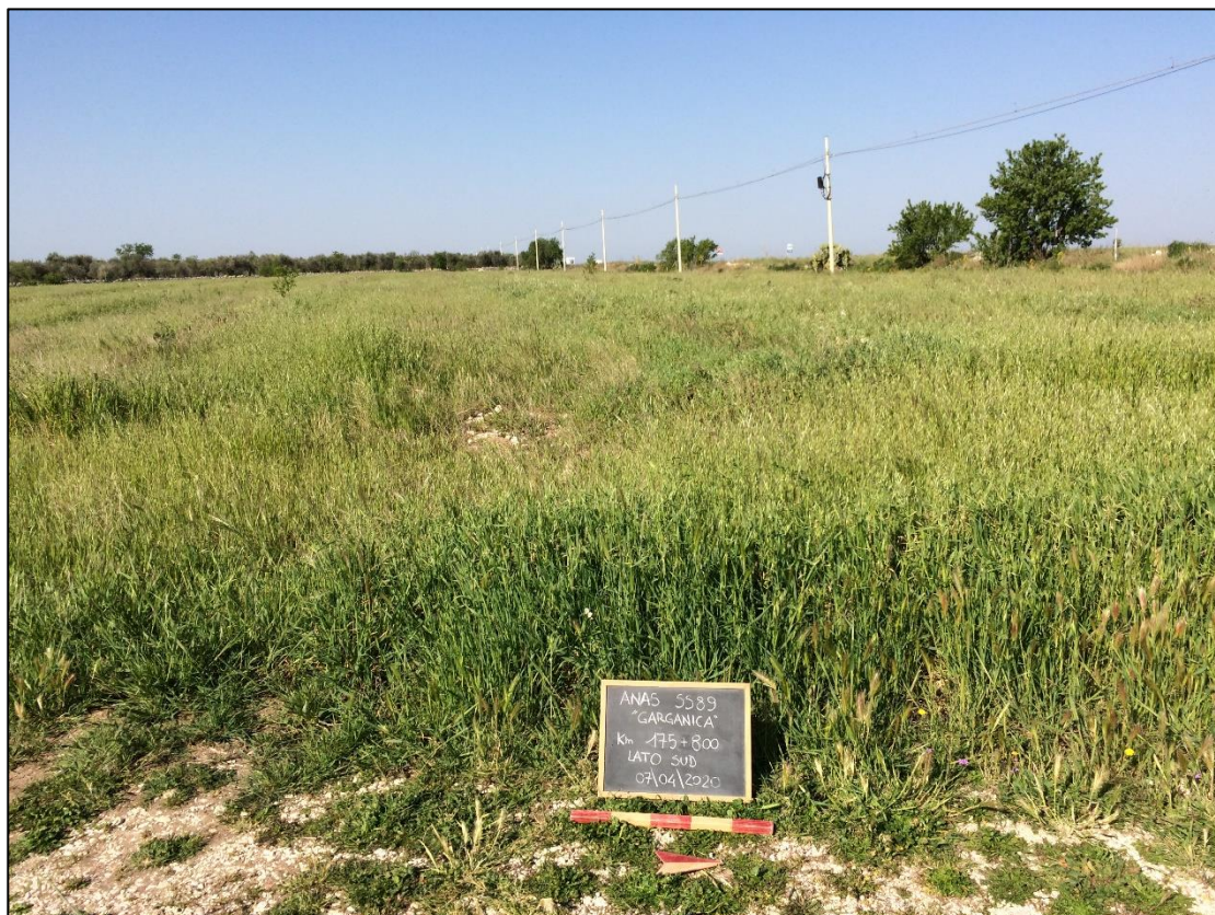
Figura 31. S.S. 89, lato sud, km 175+800
