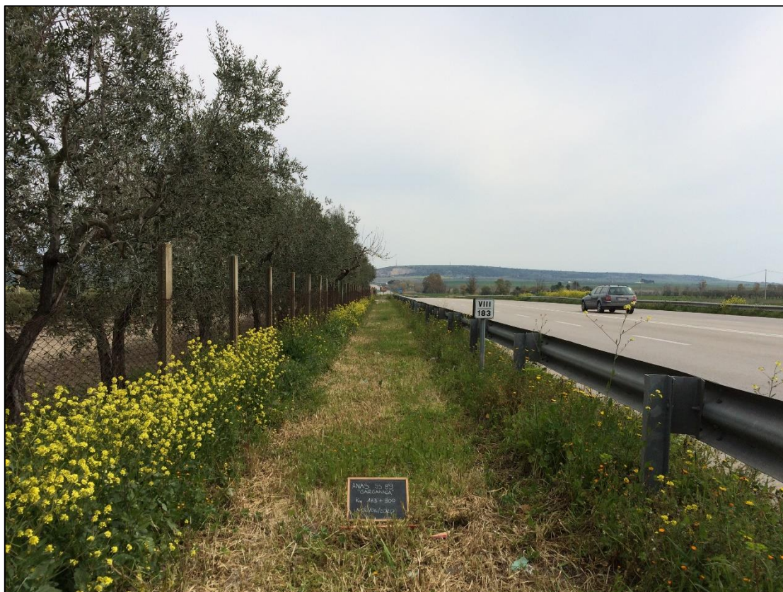
Figura 6. S.S. 89, lato nord, km 183+800
