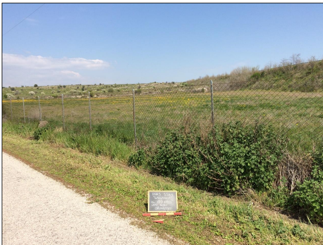
Figura 25. S.S. 89, lato nord, km 179+800
