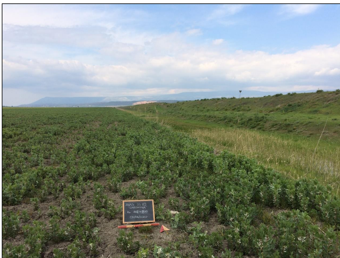
Figura 7. S.S. 89, lato nord, km 182+700
