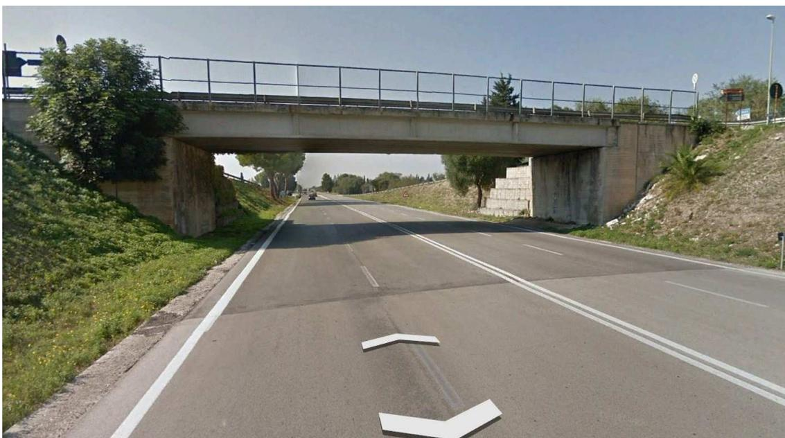
Anche in questa circostanza, così come per gli scavalchi prefabbricati dello svincolo esistente, si è studiata la compatibilità della luce interna del cavalcavia con il calibro di una sezione di tipo B. L'uso dei redirettivi come sistema di ritenuta laterale permette di gestire il passaggio graduale delle corsie da 3,75 in progetto a 3,50 dell'esistente così come la variazione delle banchine esterne ed interne.
