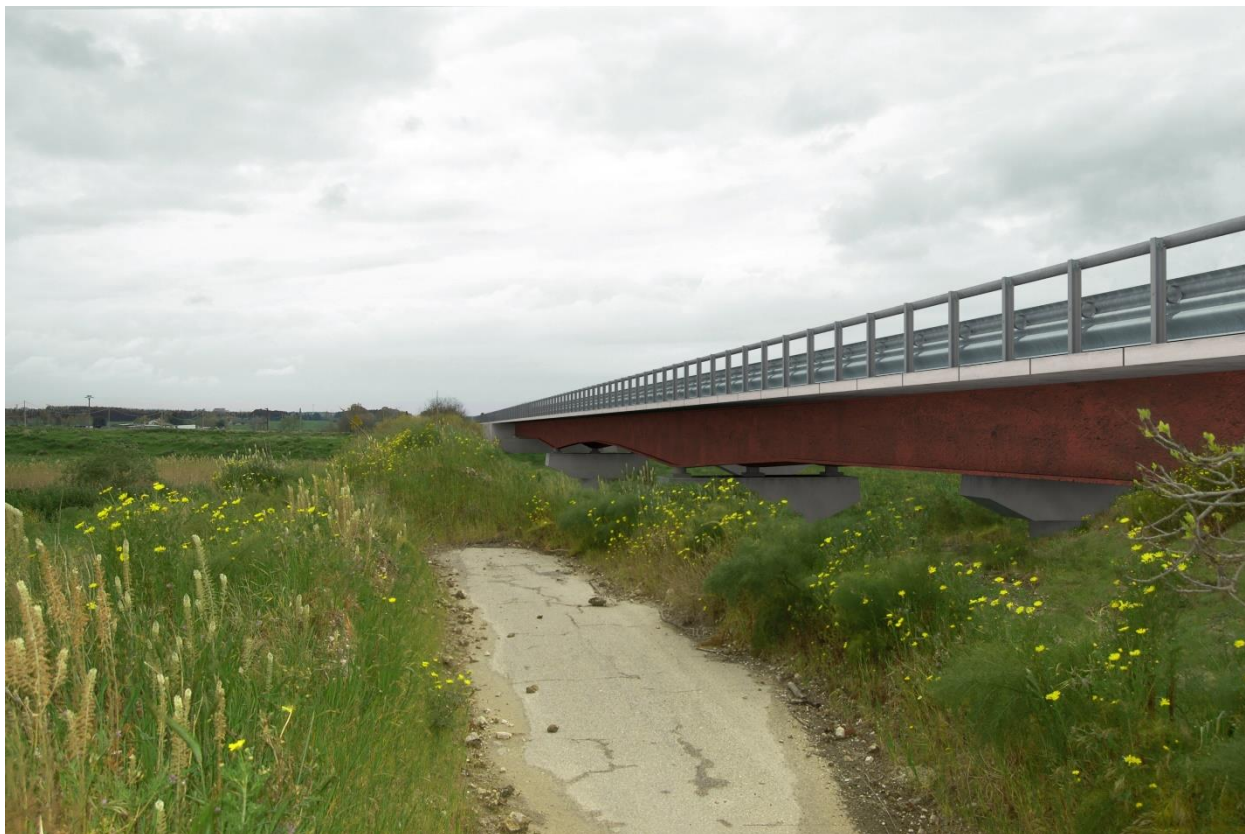
Figura 5-8 Viadotto Candelaro post operam
