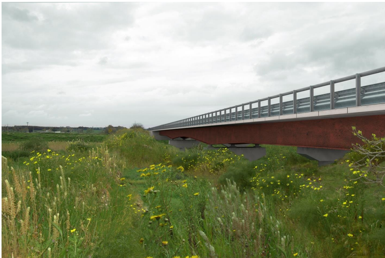
Figura 5-9 Viadotto Candelaro post operam con mitigazione
