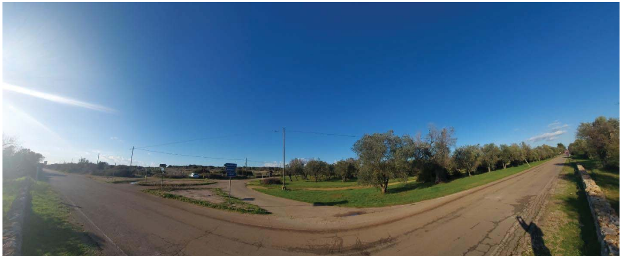
Figura 140 Stato di fatto – SP144 Avetrana
