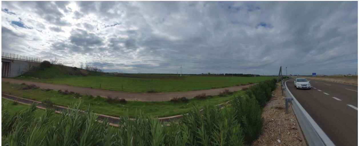
Figura 80 Stato di fatto – SS7 ter Masseria Torre Vecchia
