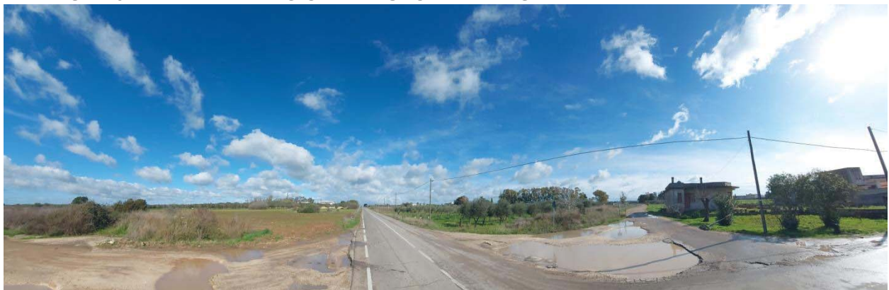
Figura 86 Stato di fatto – SP143 Avetrana
