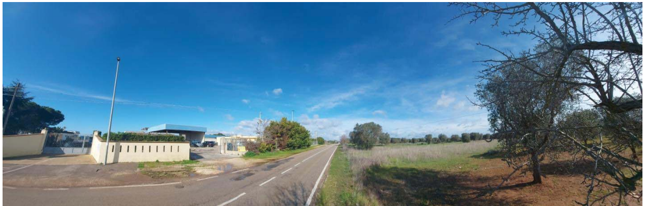
Figura 88 Stato di fatto – SP143 Masseria Bosco
