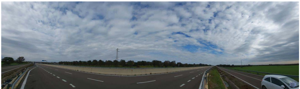
Figura 76 Stato di fatto – SS7 ter Masseria l'Argentone
