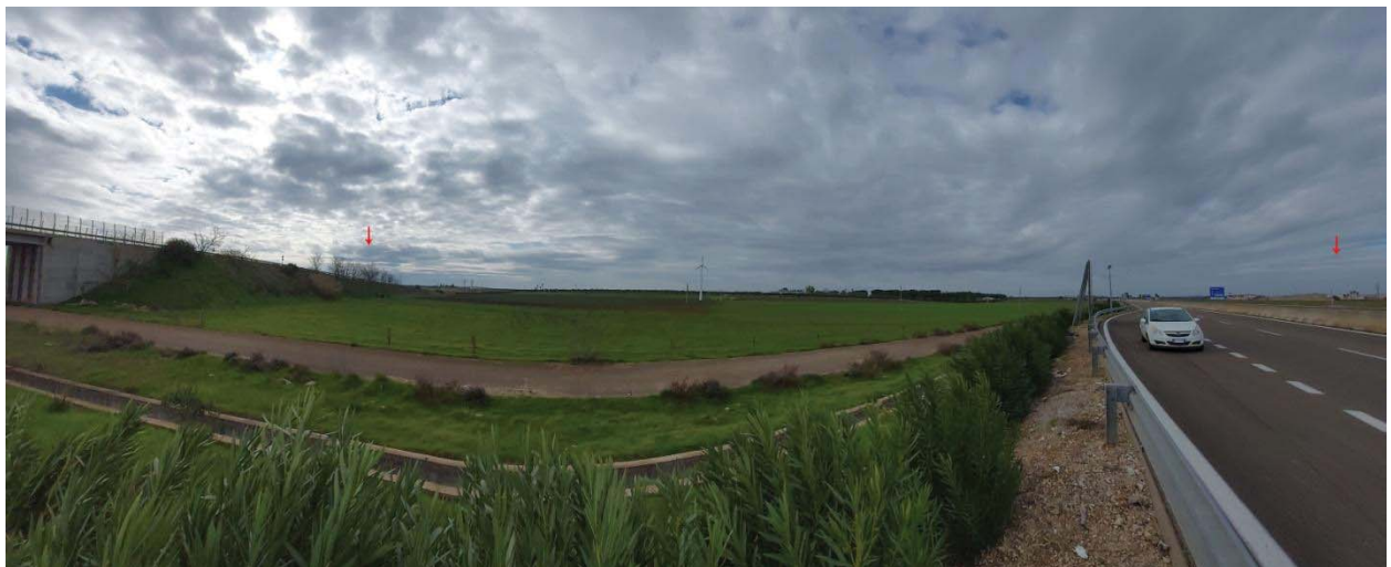
Figura 81 Fotoinserimento – SS7 ter Masseria Torre Vecchia
