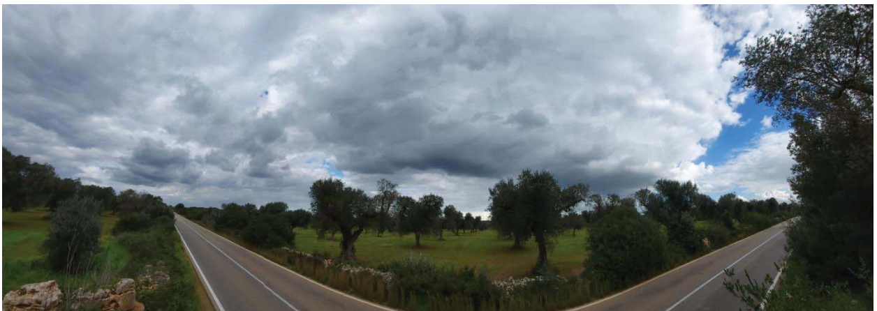
Figura 126 Stato di fatto – SP359 Avetrana
