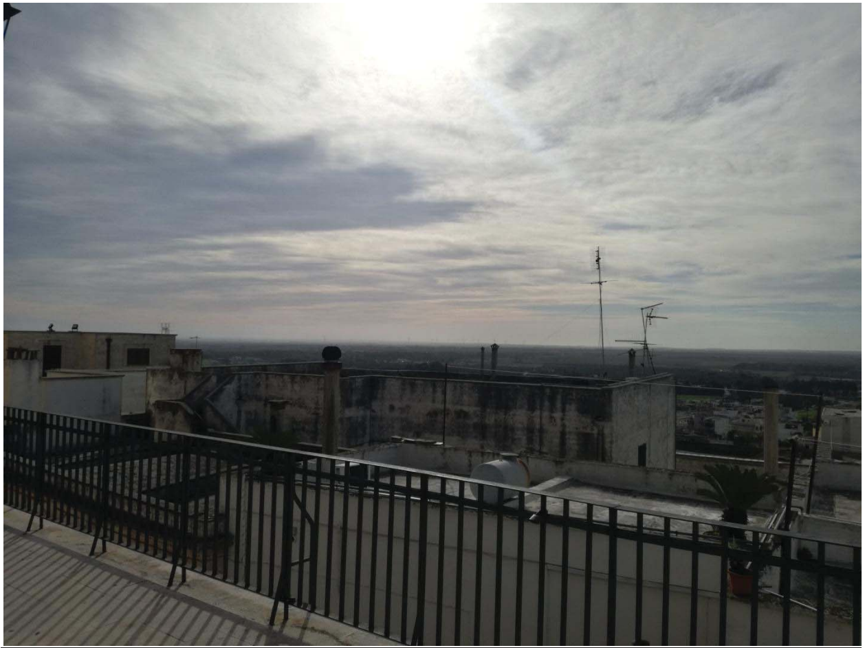
Figura 10 Stato di fatto – Castello Svevo
