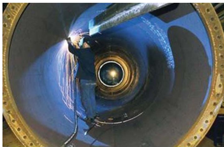
Figura 11: Interno di una torre
