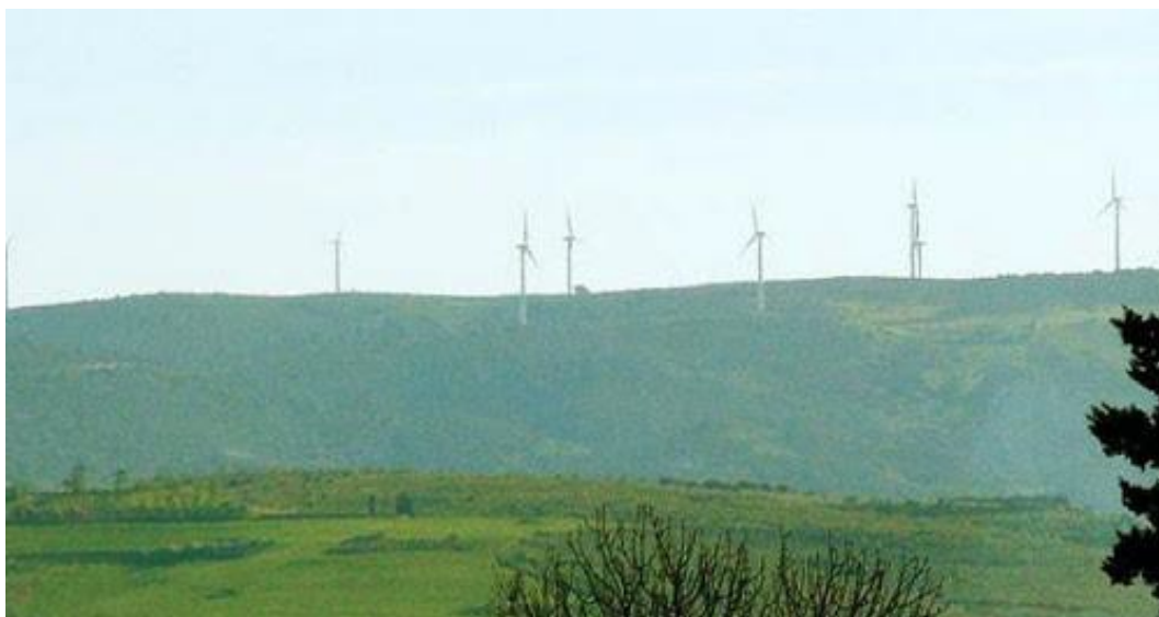
Parco eolico ubicato nella stessa area
